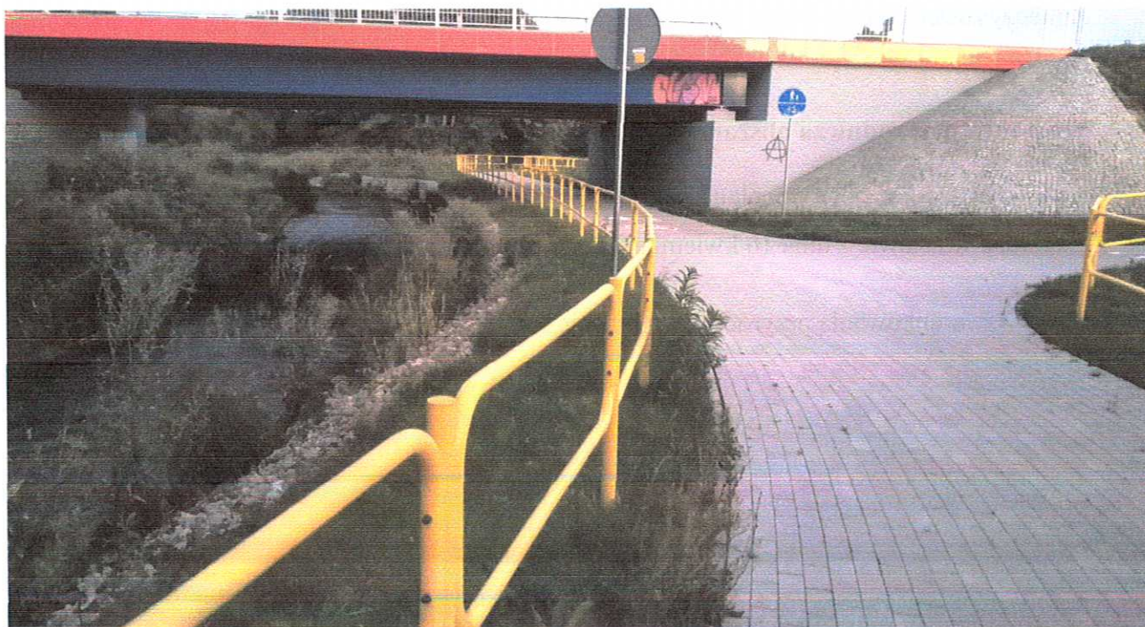
Fot 2. Ścieżka rowerowa przy moście nad Czarną Hańczą w ciągu ulicy 100-lecia Niepodległości
