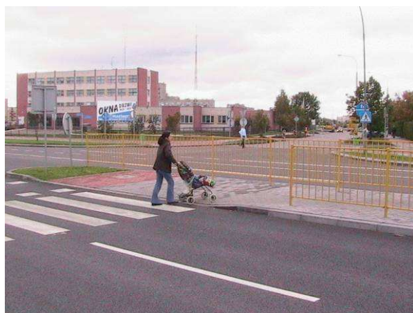
Fot. 18. Ul. Utrata – rozwiązanie przejścia dla pieszych zabezpiecza przed wtargnięciem pieszych na jezdnię ulicy
