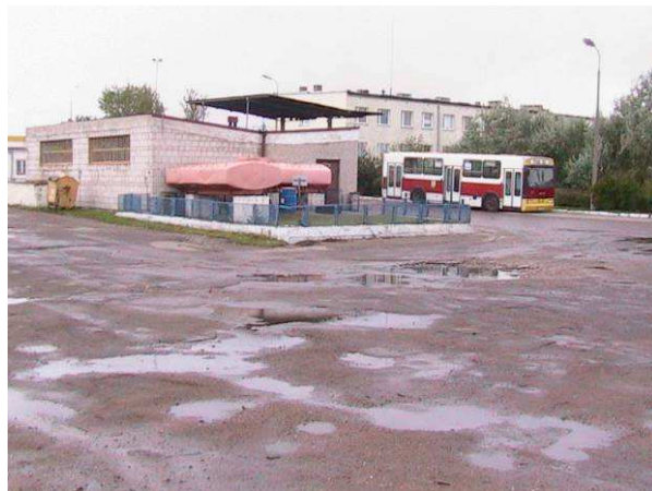
Fot. 16. Zajeżdźnia Zakładu Komunikacji Miejskiej PGK - stacja paliw.
