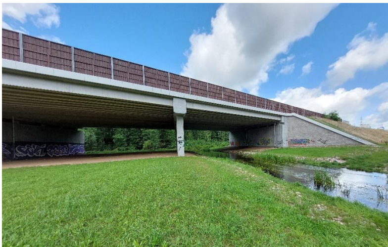
Fot. 2. Widok na Czarną Hańczę z biegiem rzeki spod mostu drogi ekspresowej S61
