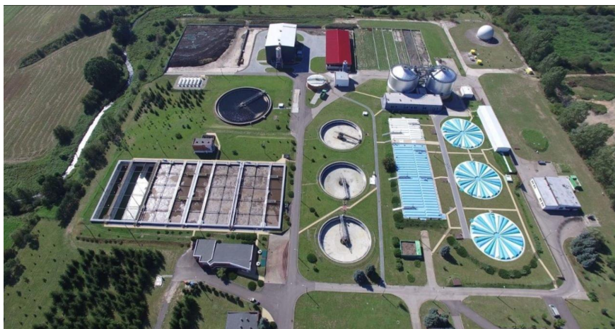
Fot. 33. Miejska oczyszczalnia ścieków w Suwałkach
