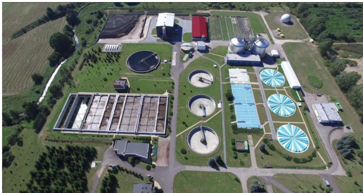
Fot. 33. Miejska oczyszczalnia ścieków w Suwałkach
