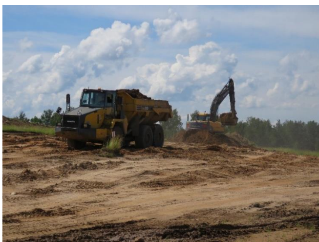
Fot. 43. Usuwanie wierzchniej warstwy ziemi przy realizacji drogi S-61 przy północno-wschodniej granicy miasta Suwałk
