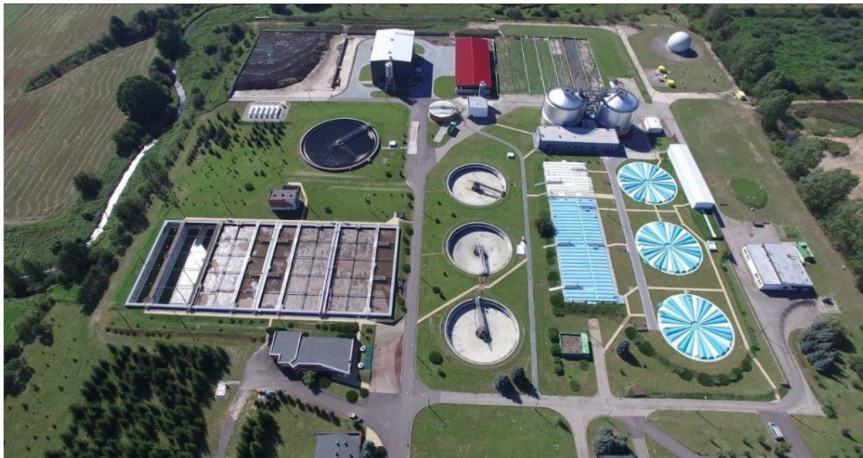
Fot. 33. Miejska oczyszczalnia ścieków w Suwałkach
