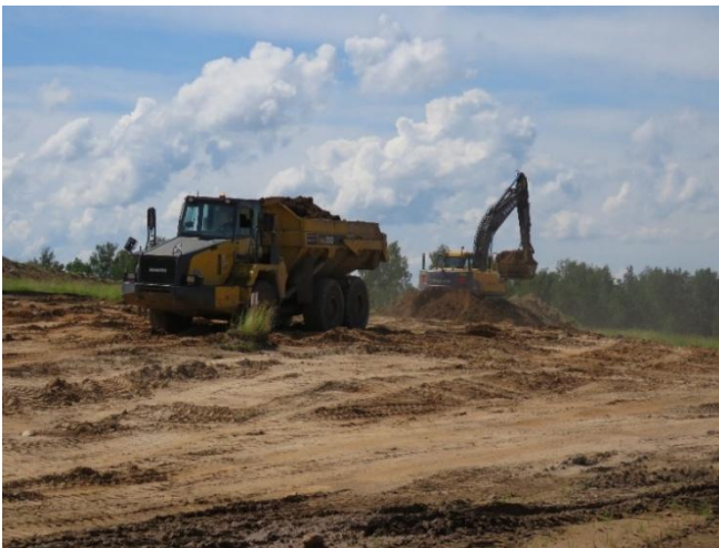
Fot. 43. Usuwanie wierzchniej warstwy ziemi przy realizacji drogi S-61 przy północno-wschodniej granicy miasta Suwałk
