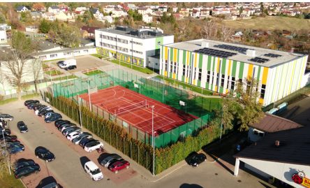
Rozbudowa SP nr 4 w Suwałkach.
