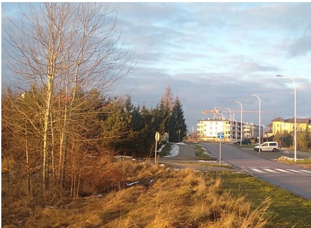
Fot. 1. Ulica Krakowska – widok na realizowaną zabudowę wielorodzinną
