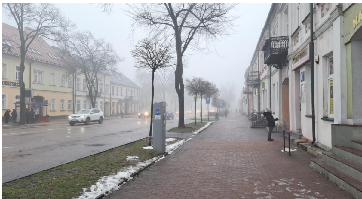
Ryc. 53 Ul. Kościuszki - parterzy wyniesione o pół kondygnacji.
