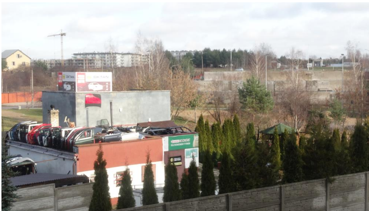
Fot. 6. Zagospodarowanie nieruchomości dawnej palarni kawy
