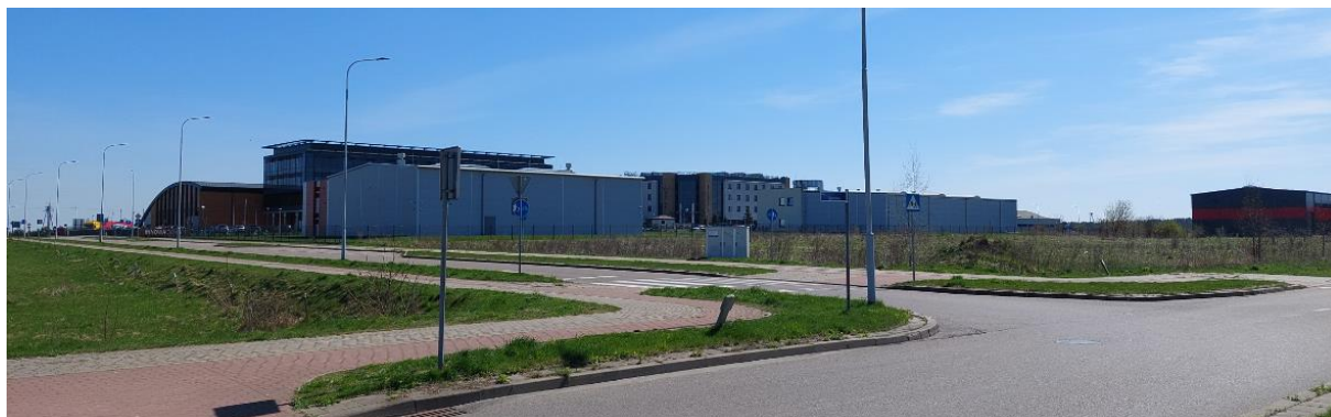
Fot. 1. Widok na obszar objęty opracowaniem planu, widok od strony skrzyżowania ul. Walerego Romana i ul.Sportowej. Na pierwszym planie budynki przemysłowe, na drugim Park Naukowo-Technologiczny i Hotel Szyszko.
