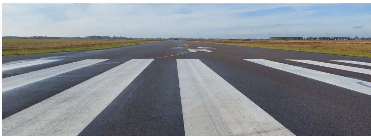
Fot. 3. Główna droga startowa o nawierzchni sztucznej dł. 1320 m i szer. 30 m
