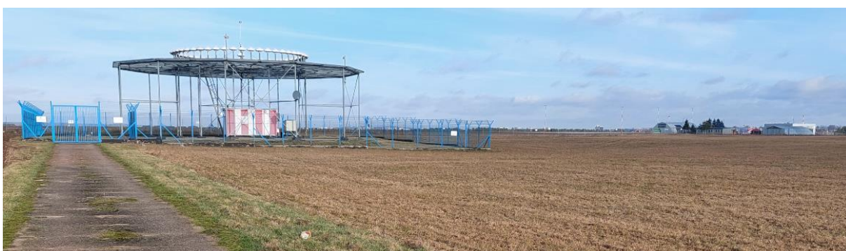
Fot. 5. Radiolatarnia DVOR/DME i zabudowania lotniska (w głębi po prawej stronie zdjęcia)
