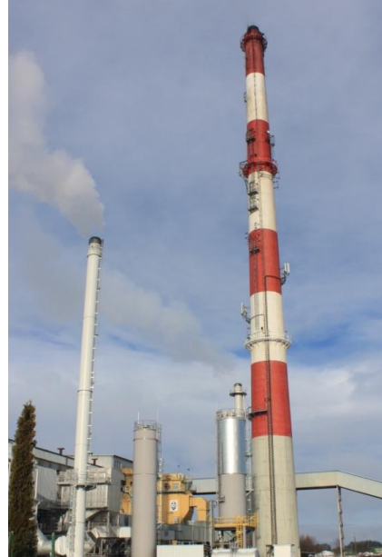
Widok ciepłowni,, fot. z archiwum PEC w Suwałkach Sp. z o.o.
