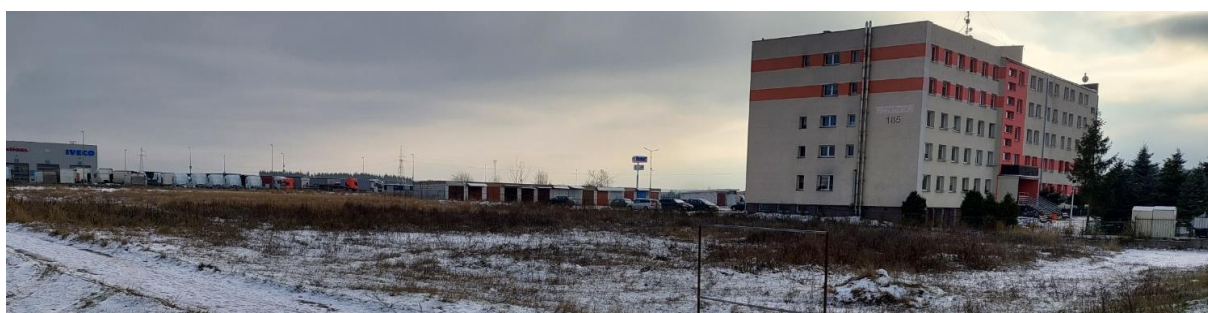
Fot. 3. Widok na obszar opracowania od strony północnej od skrzyżowania ulicy Szafirowej z ulicą Raczkowską
