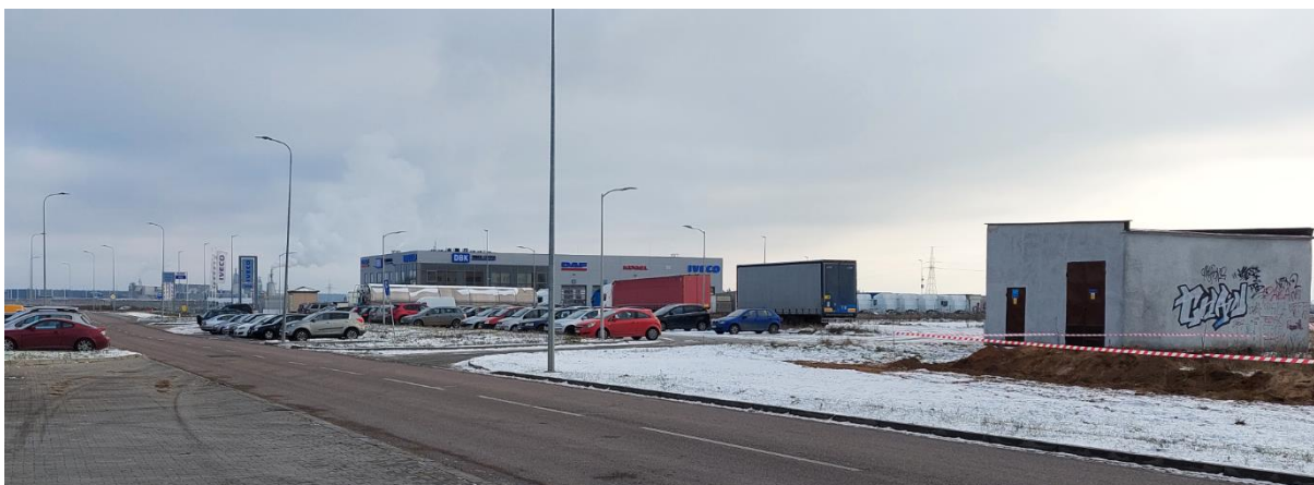
Fot. 4. Widok na obszar opracowania od strony ulicy Szafirowej, po prawej stronie zdjęcia widoczna stacja transformatorowa, w centrum zdjęcia parking dla samochodów osobowych i ciężarowych
