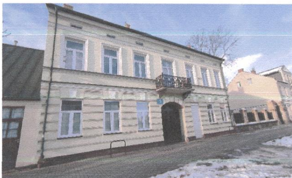
Dom nr 5, murowany, poł XIX w., nr rej. 155
