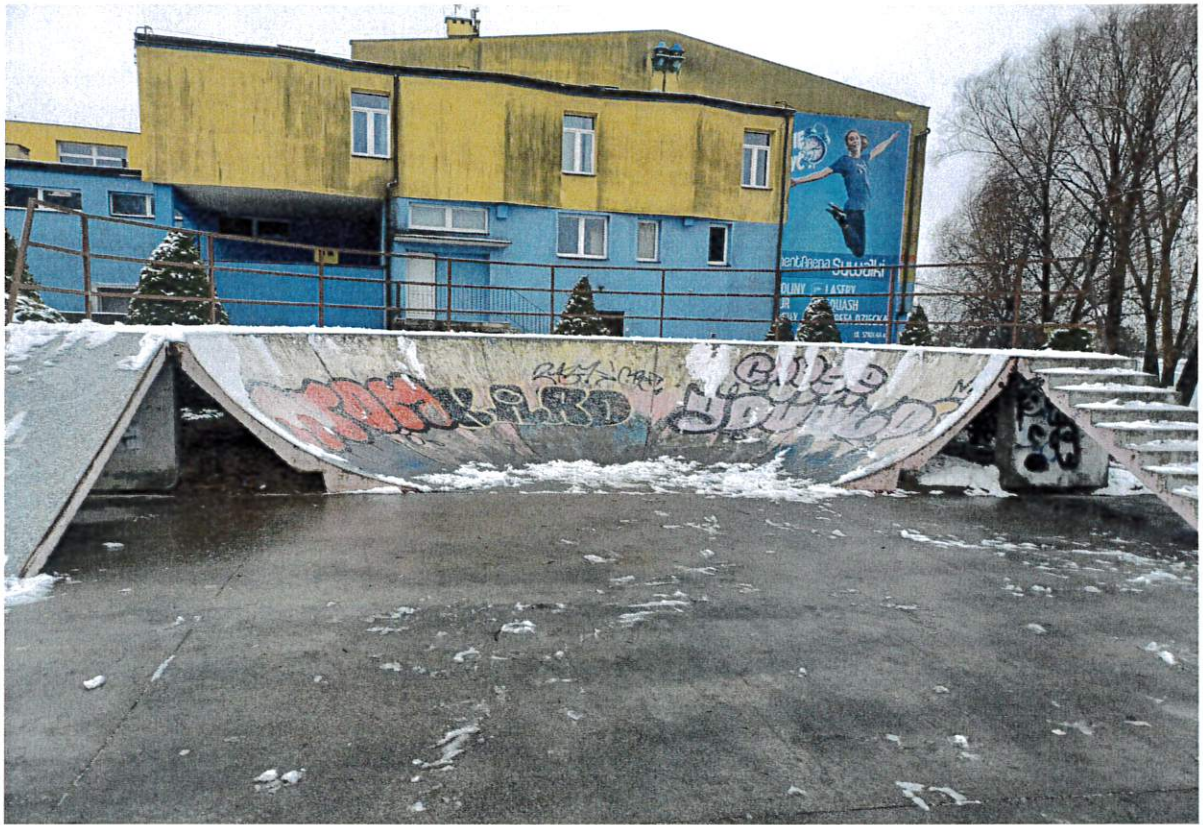
Fot nr 5 Rampa 1 – widok od czoła
