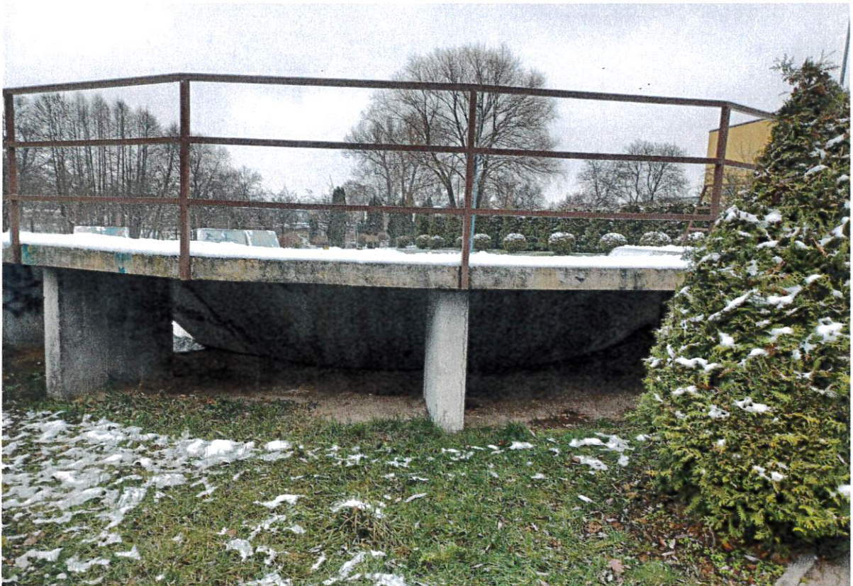
Fot nr 6 Rampa 1 – widok z tyłu
