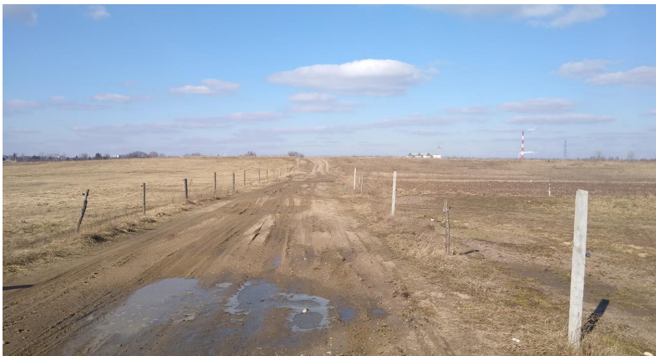
Fot. 1. Gruntowa droga w ciągu ulicy Siwnożęc – widok w kierunku północnym
