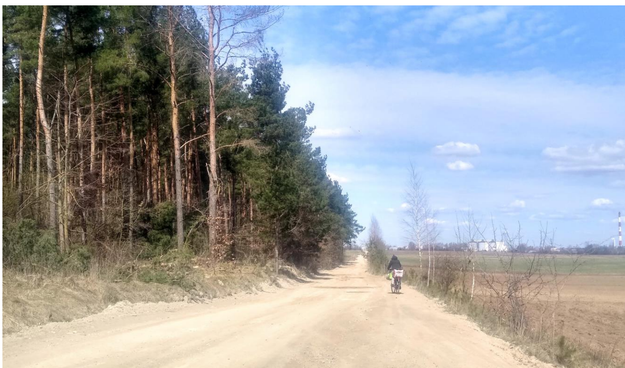
Fot. 11. Gruntowa droga w ciągu ulicy Sianożęć – odcinek przy terenie leśnym
