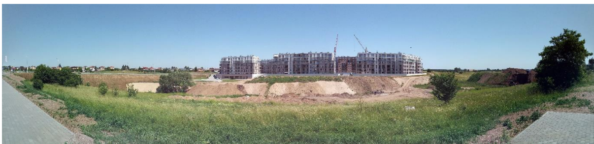
Fot.7 Panorama nowopowstającego Osiedla Sobola Biel od ulicy Sportowej (widoczne obniżenie terenu)
