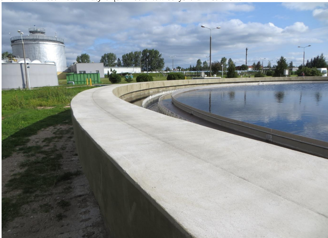
Nowe torowisko osadnika nr 4 na oczyszczalni ścieków fot. Przedsiębiorstwo Wodociągów i Kanalizacji w Suwałkach, fot. archiwum Przedsiębiorstwa Wodociągów i Kanalizacji w Suwałkach Sp. z o.o.
