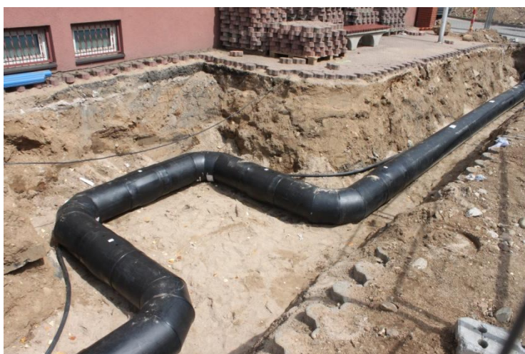
Budowa sieci ciepłowniczej, fot. archiwum PEC w Suwałkach Sp. z o.o
