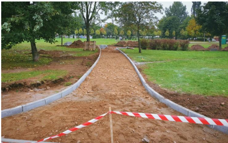
Budowa alejki w Parku Północnym, fot. z archiwum ZDiZ w Suwałkach.
