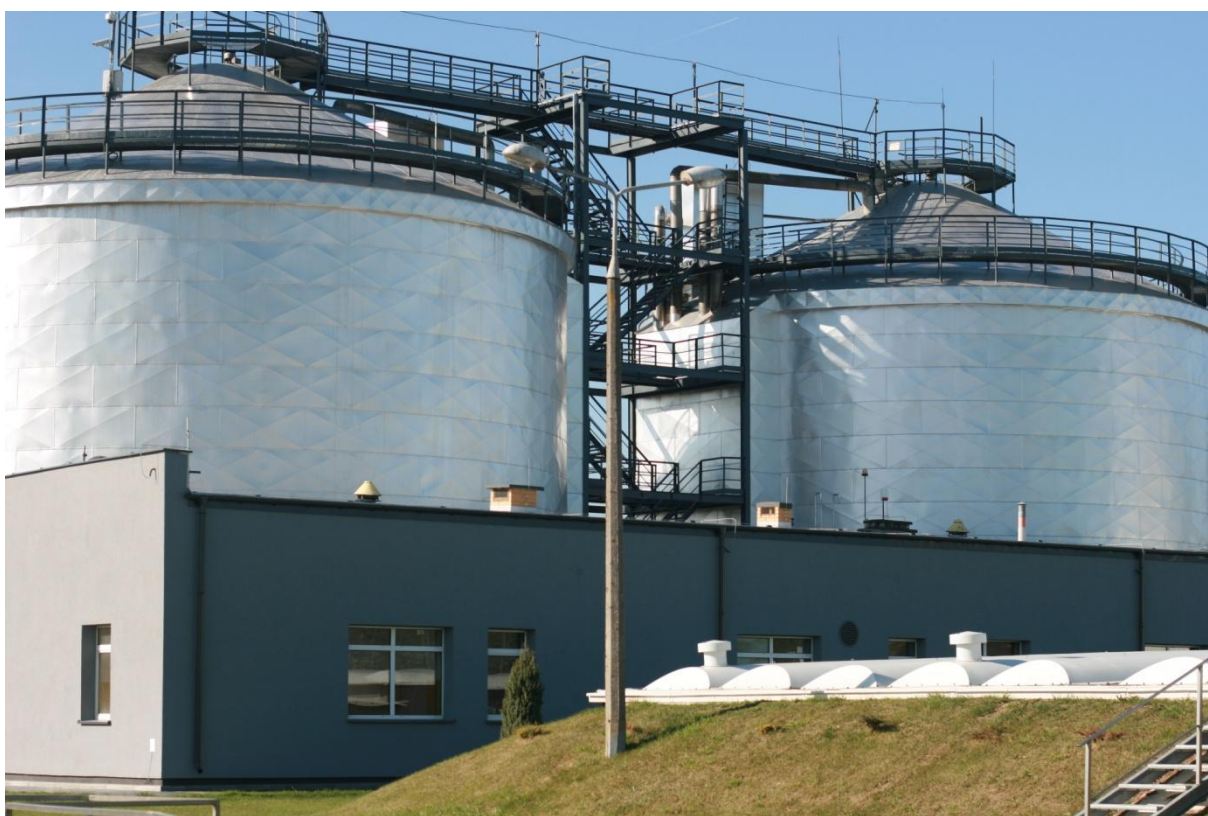
Termomodernizacja dwóch komór fermentacyjnych na oczyszczalni fot. Przedsiębiorstwo Wodociągów i Kanalizacji w Suwałkach, fot. archiwum Przedsiębiorstwa Wodociągów i Kanalizacji w Suwałkach Sp. z o.o.
