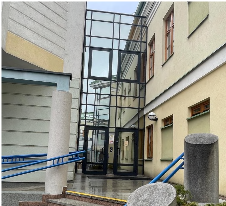
Fot. 3. Istniejące okno do wymiany na naświetle EI 15. Lampa zewnętrzna do przeniesienia.
