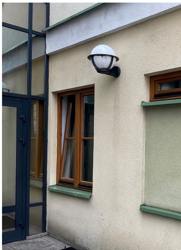
Fot. 3. Istniejące okno do wymiany na naświetle EI 15. Lampa zewnętrzna do przeniesienia.
