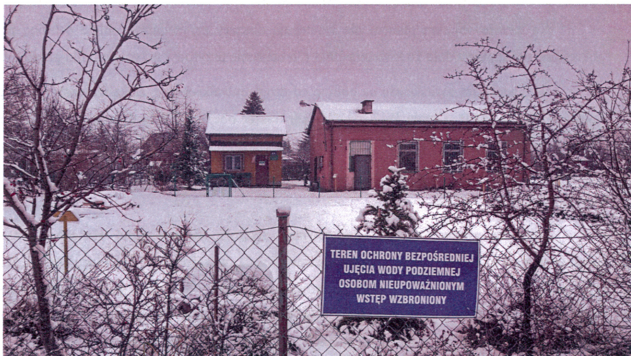
Fot 5. Strefa ochronna ujęcia wody i biuro ROD „Malwa”
