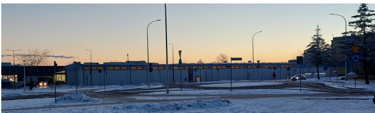
Fot. 5 Wybudowane w 2021 roku rondo na ul. Daszyńskiego
