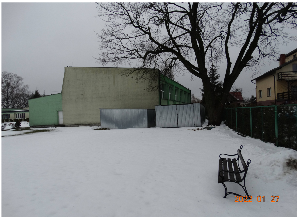
Fot nr 2 Sala gimnastyczna z zapleczem / do rozbiórki/ - widok od strony południowej
