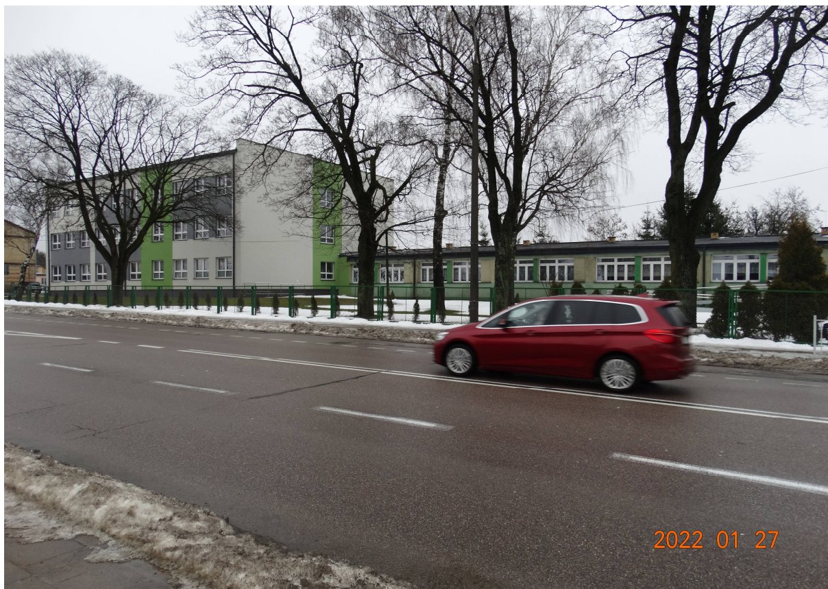
Fot nr 7 Ci dalszy elewacji zachodniej z nowym pawilonem wybudowanym w latach 2019-2020
