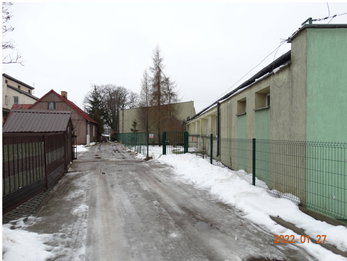
Fot nr 11 Elewacja wschodnia ciąg dalszy
