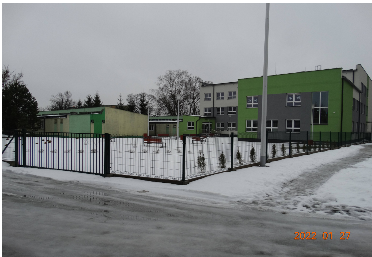
Fot nr 10 Elewacja wschodnia
