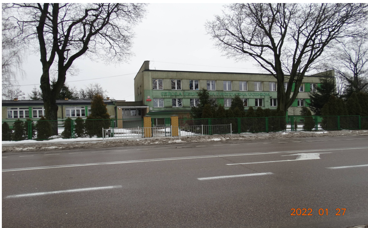
Fot nr 6 Elewacja zachodnia z wejściem głównym do szkoły
