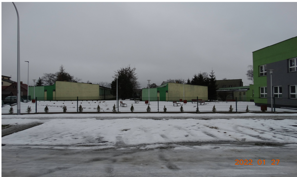
Fot nr 9 Elewacja północna ciąg dalszy
