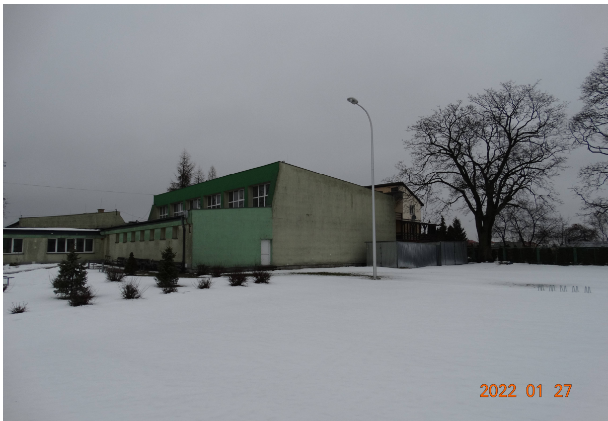
Fot nr 1 Sala gimnastyczna z zapleczem / do rozbiórki/ - widok od strony południowej
