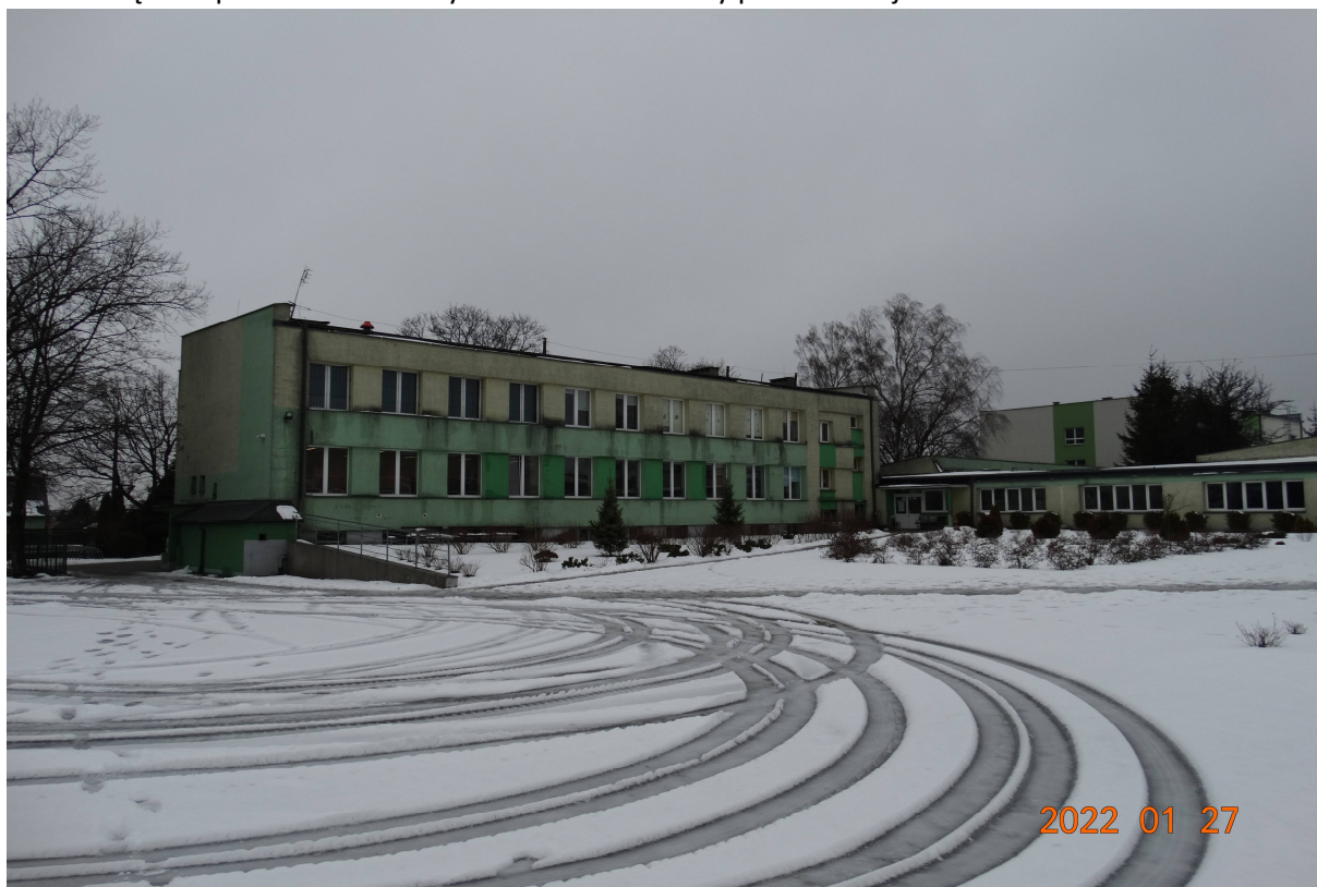
Fot nr 4 Pawilon trzykondygnacyjny – widok od strony południowo – wschodniej
