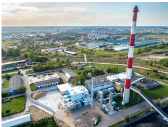
Instalacja spalania biomasy, fot. z archiwum Przedsiębiorstwa Energetyki Ciepłej w Suwałkach Sp. z o.o.
