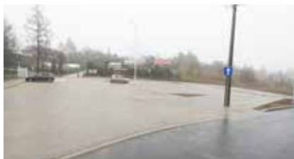
Parking i zatoka autobusowa MPK w centrum ogródków działkowych na Osiedlu Północ w Suwałkach (ulica Wyszyńskiego), fot. z archiwum Urzędu Miejskiego w Suwałkach
