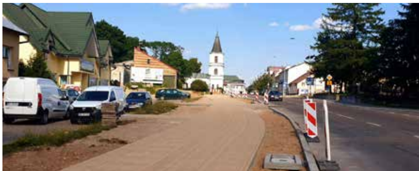
Budowa chodnika- ul. Mickiewicza, fot. z archiwum ZDiZ w Suwałkach
