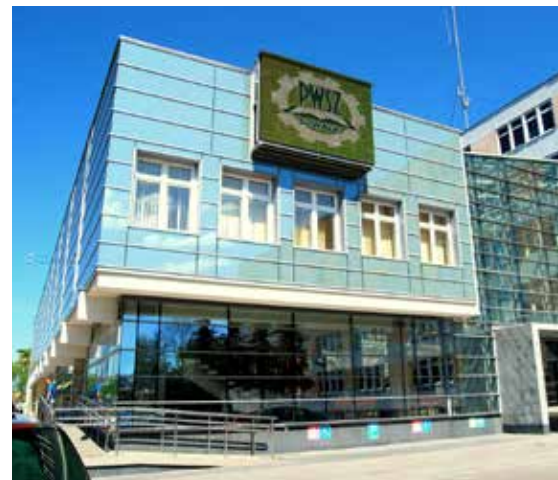
Budynek Państwowej Wyższej Szkoły Zawodowej im. prof. Edwarda F. Szczepanika w Suwałkach, fot. z archiwum PWSZ.
