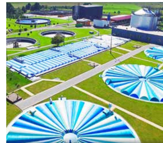
Oczyszczalnia ścieków, fot. z archiwum Przedsiębiorstwa Wodociągów i Kanalizacji w Suwałkach Sp. z o.o.
