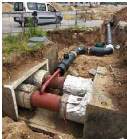
Termomodernizacja sieci przy ul. Pileckiego, fot. z archiwum Przedsiębiorstwa Energetyki Ciepłej w Suwałkach Sp. z o.o.
