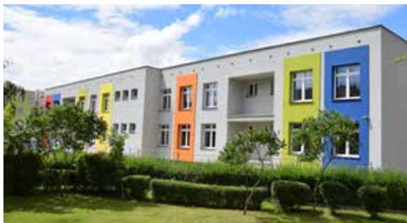
Przedszkole nr 7 po remoncie, fot. z archiwum Urzędu Miejskiego w Suwałkach
