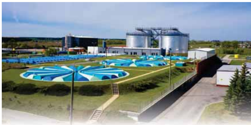
Oczyszczalnia ścieków, fot. Przedsiębiorstwo Wodociągów i Kanalizacji w Suwałkach
