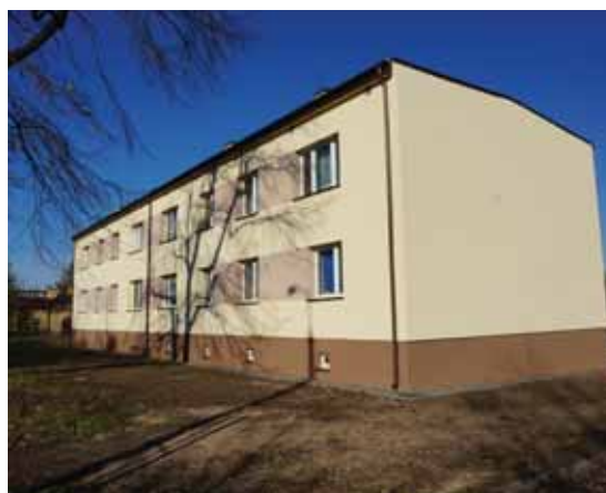
Budynek Wspólnoty Mieszkaniowej przy ul. Waryńskiego 33 po termomodernizacji
