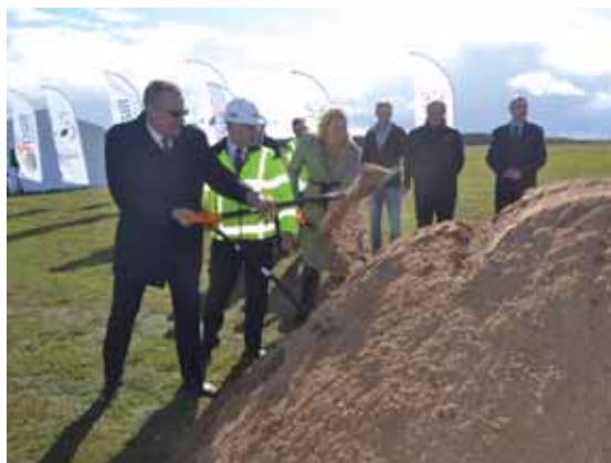
Wbicie łopaty pod budowę lotniska
