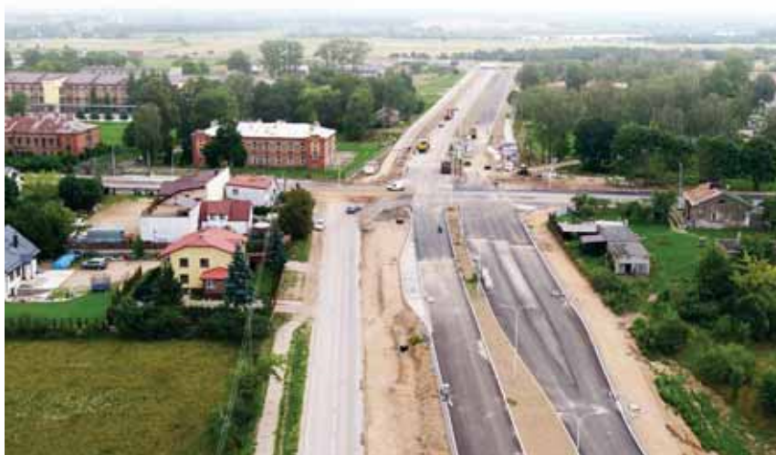
Budowa ul. Leśnej
