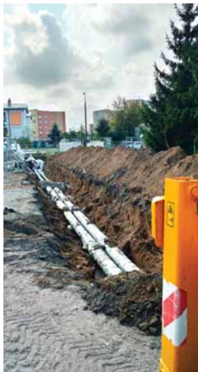
Termomodernizacja sieci, fot. Przedsiębiorstwo Energetyki Ciepłej w Suwałkach
