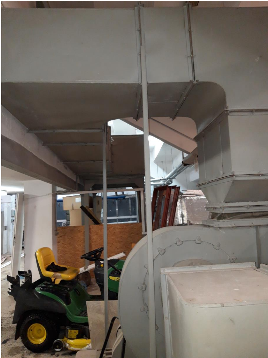
Istniejąca nie działająca instalacja wentylacji – do likwidacji
