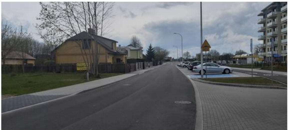
Widok na ul. Szczęsnowicza w kierunku ul. Reja
