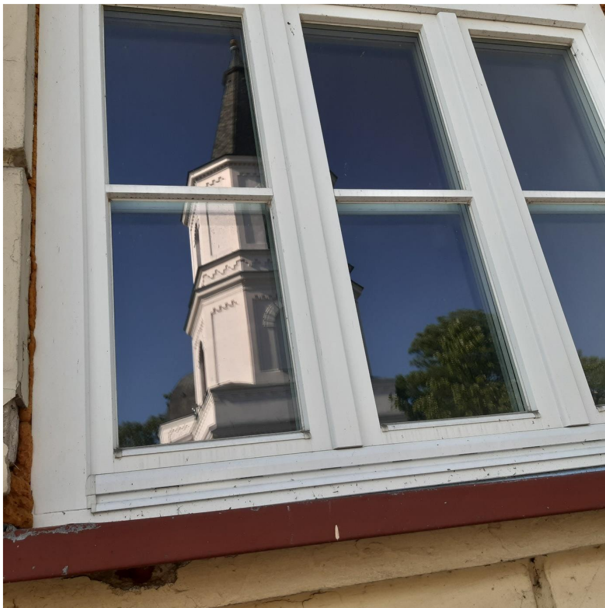
Fot nr 1 Okna wymienione w 2020r. z widocznymi szprosami.
