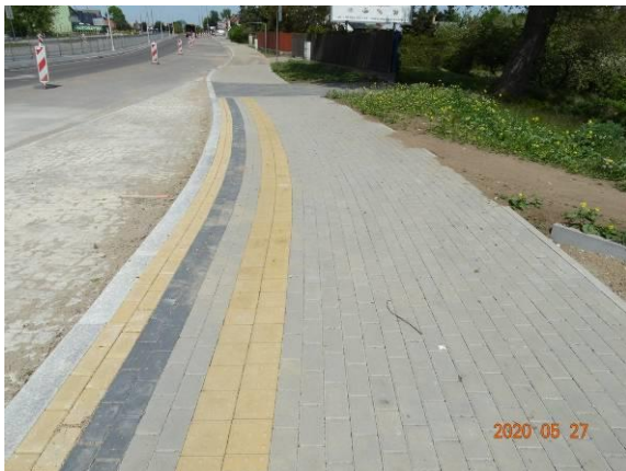
62. Brak spoinowania chodnika i peronu na ul. Utrata strona wschodnia (od ronda w kierunku miasta)
