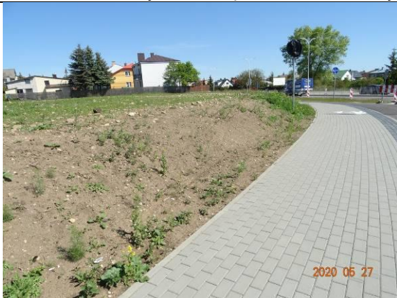
66. Brak spoinowania kostki betonowej (obręb ronda wlot ul. A Piłsudskiej – str. zachodnia)
