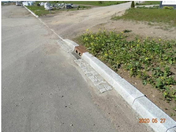
71. Brak właściwego spoinowania kostki przy wpustach na zatoce ITD
