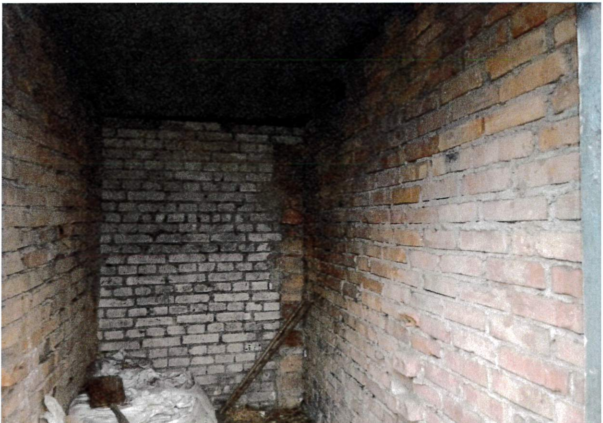
Fot nr 5 Widok na komórkę
