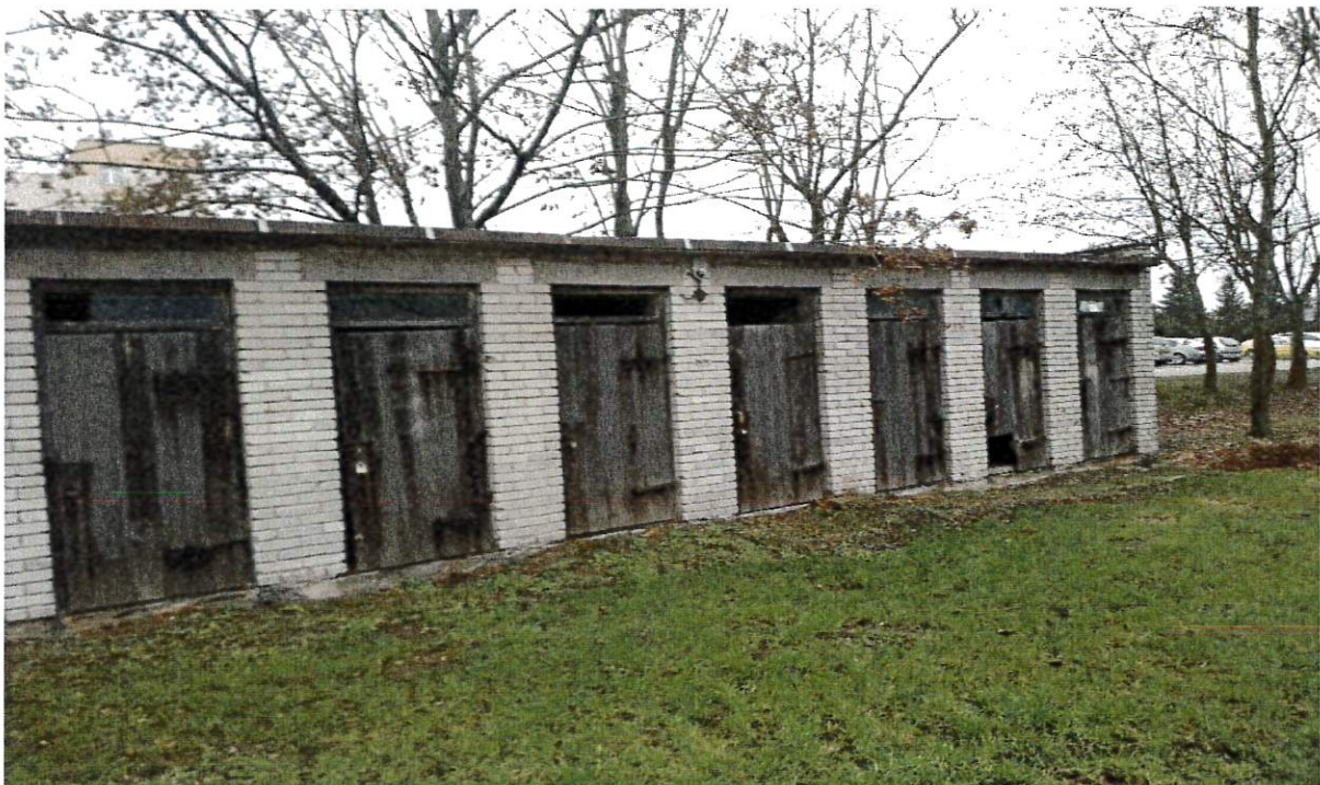
Fot nr 1 Elewacja południowa budynku
