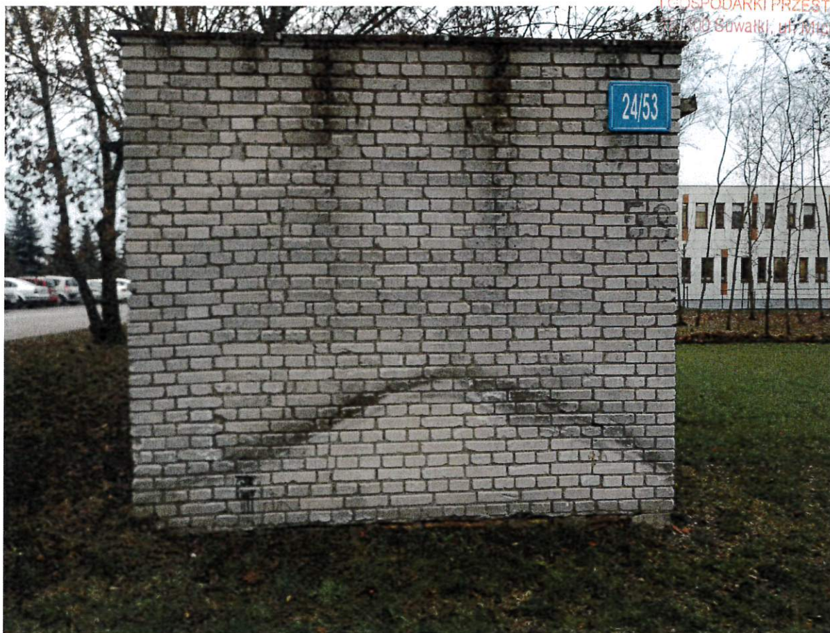
Fot nr 2 Elewacja zachodnia
