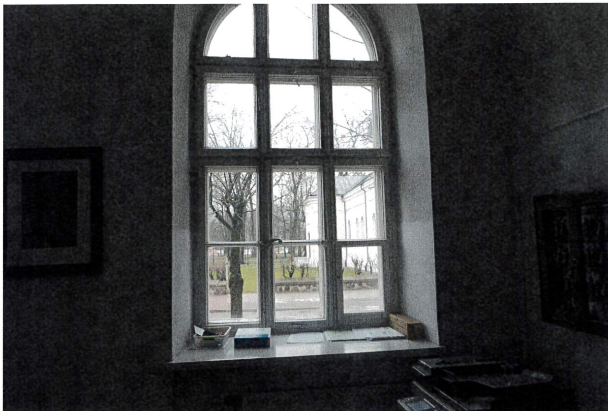
Fot nr 3 Okno O5 – parter
