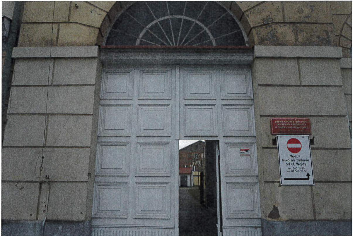
Fot nr 9 – wrota wejściowe z naświetlem. Pomiędzy wrotami i naświetlem belka drewniana. Widok od ulicy.
