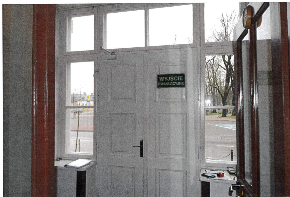
Fot nr 8 Drzwi zewnętrzne Dz2 z naświetlami
