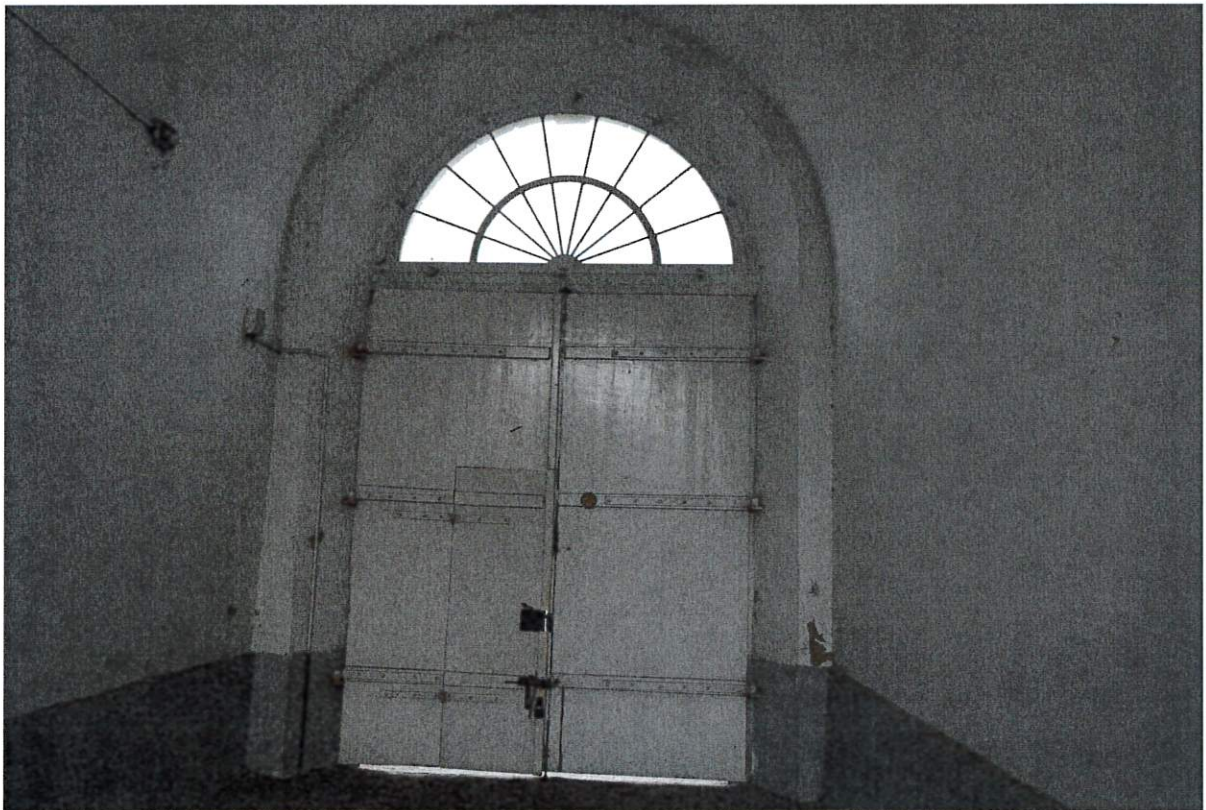
Fot nr 10 – wrota widok od podwórza
