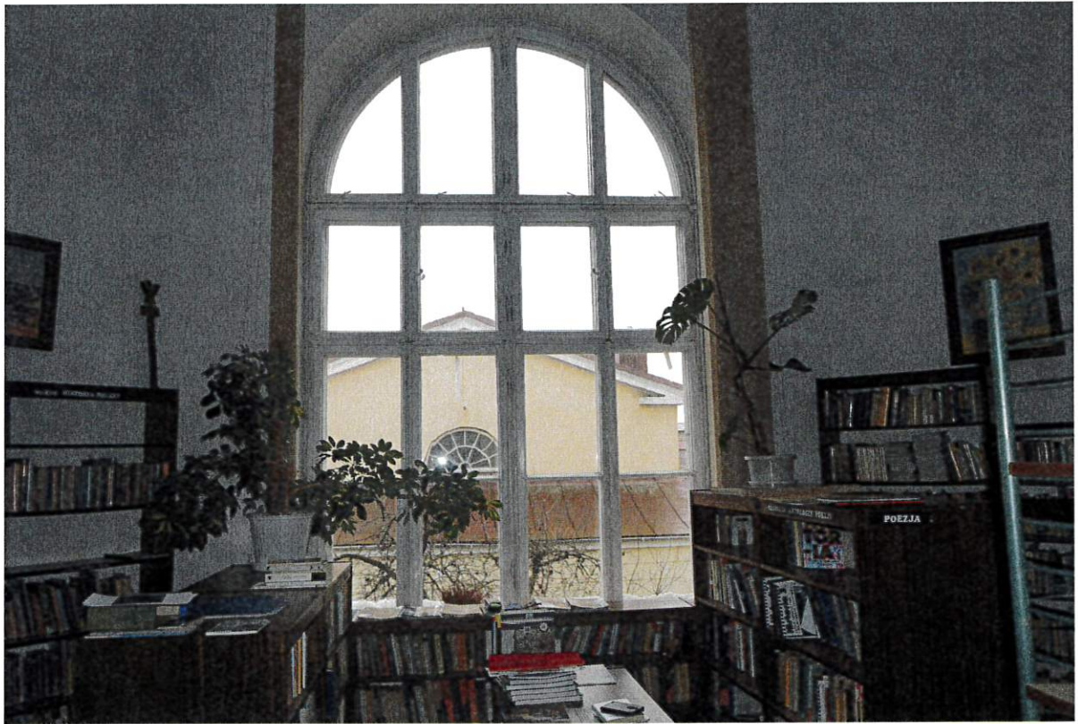
Fot nr 5 – Okno łukowe O8 – biblioteka
