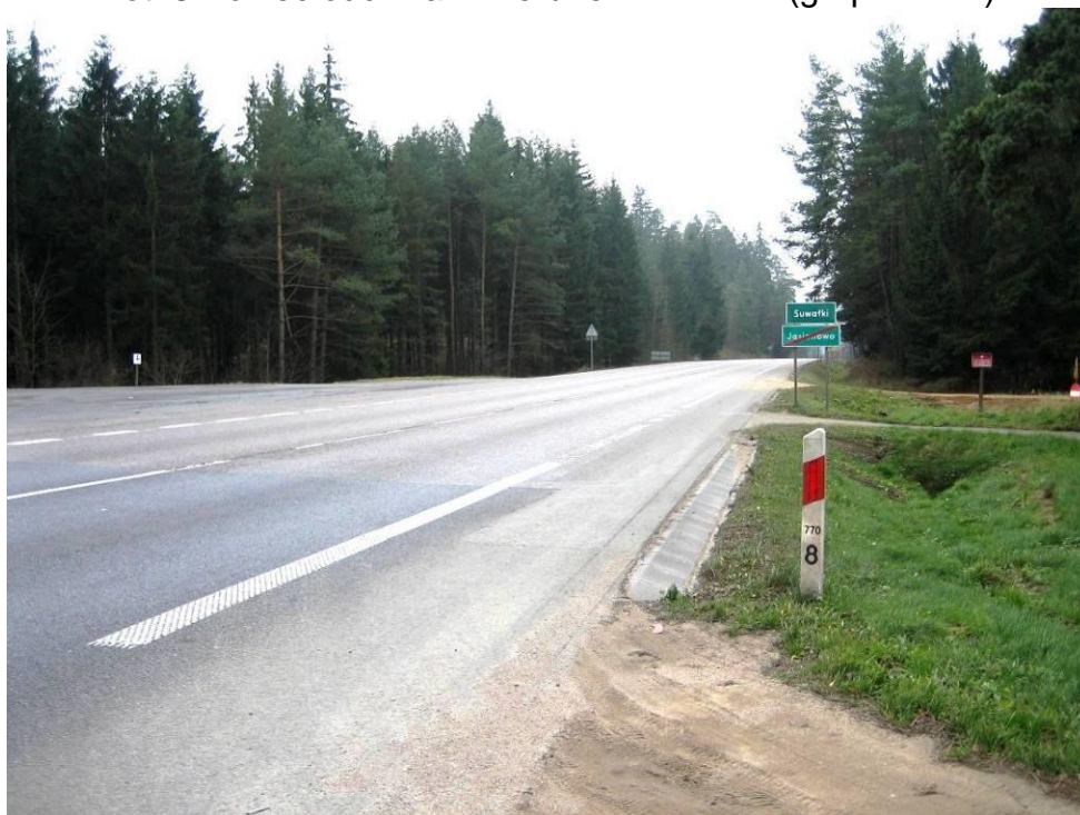
Fot. 4 Koniec odcinka – Kierunek Centrum
