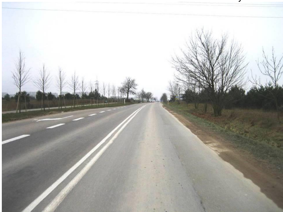
Fot. 20 Koniec odcinka – Kierunek Centrum
