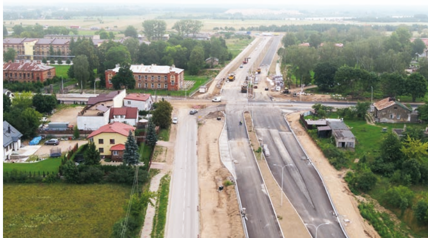
Budowa ul. Leśnej
