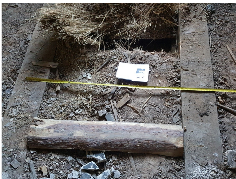
Rys. 7. Drewniane belki nośne stropu nad parterem
