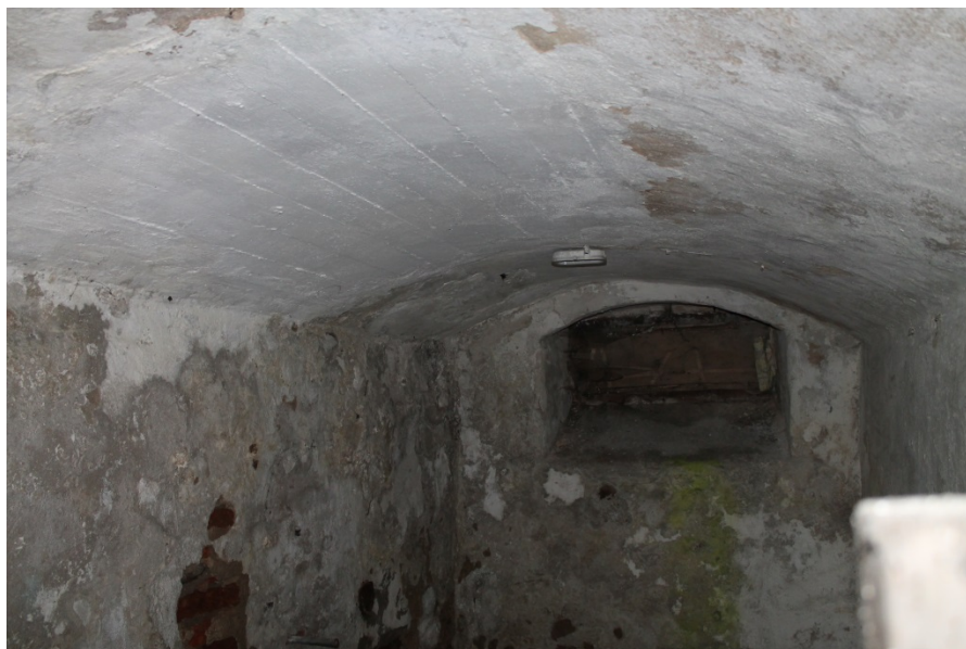
Rys. 6. Sklepienie łukowe stropu nad piwnicą
