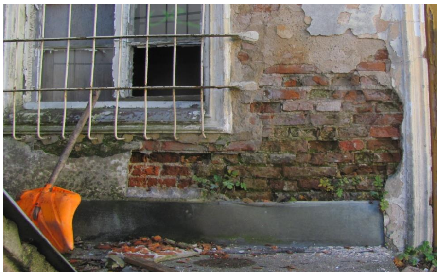
Fot. 2 Podmyty przez wody opadowe fundament narożnika Uszkodzony mur komstrukcyjny ściany zewnętrznej
