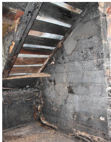
Fot. 8 Więźba dachowa uszkodzona i zniszczona w wyniku pożaru
