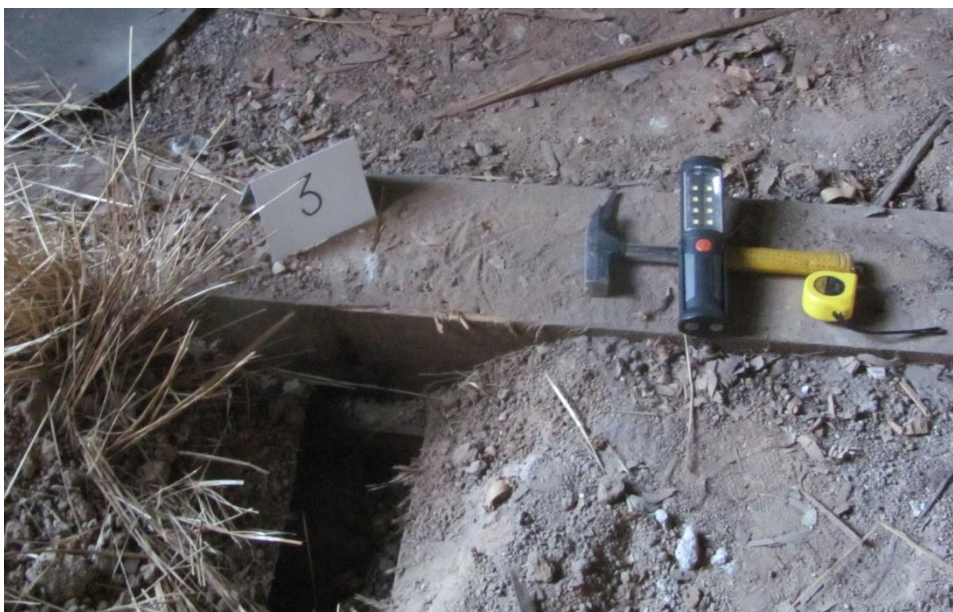
Fot. 16 Drewniana belka 22/28 stropu nad parterem w dobrym stanie konstrukcyjnym i biologicznym. Polepa z trocin i gliny.
