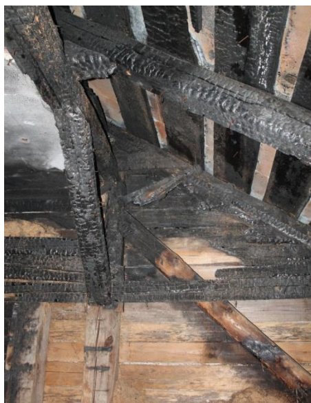
Fot. 8 Więźba dachowa uszkodzona i zniszczona w wyniku pożaru
