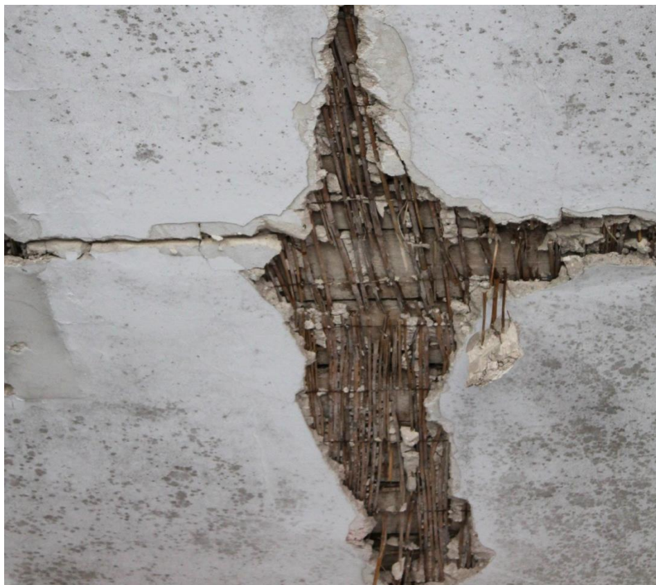
Fot. 15 Strop nad parterem .Tynk wapienno-piaskowy wykonany na matach trzciniowych.Podsufitka z desek mocowanych do belek stropowych. Na tynku widoczne czarne plamy Grzyba rozkładu plesniowego
