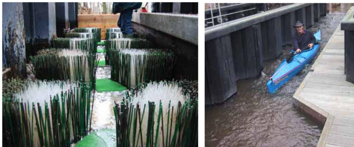
Rys. 1. Przepławka dla ryb i pochylnia dla kajaków na rzece Szprewa w miejscowości Spreewald w pobliżu Berlina (fot. Hassinger R, Kaetz D. w 4]).
