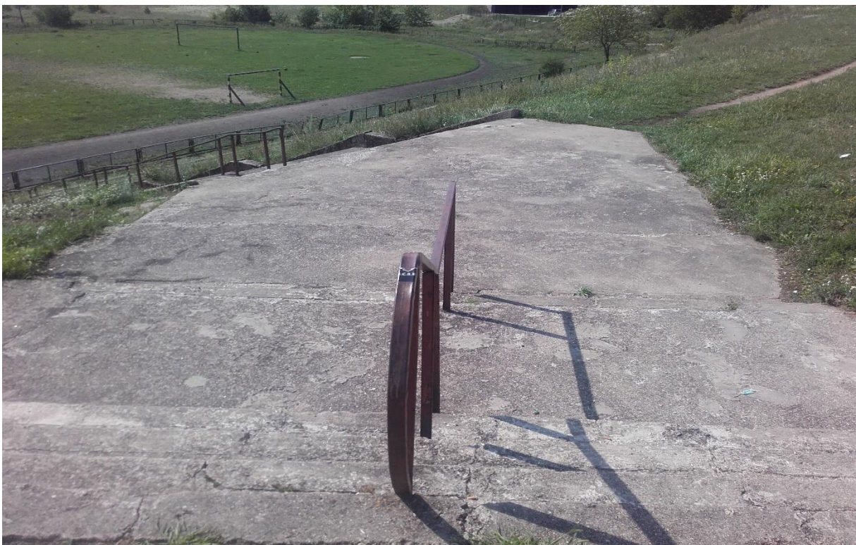
Fot nr 2 schody betonowe zejścia na boisko
