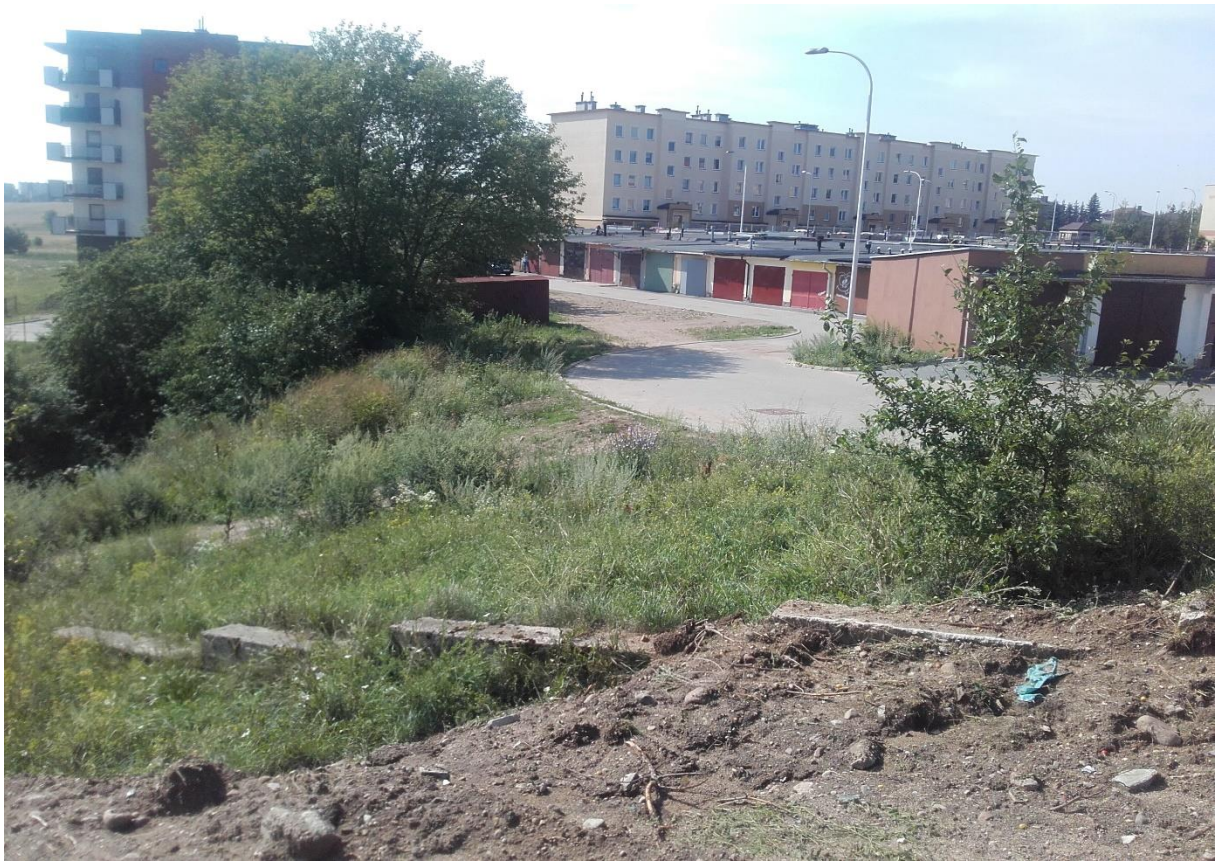
Fot. Nr 7 możliwość zjazdu od strony garaży na drogę gruntową
