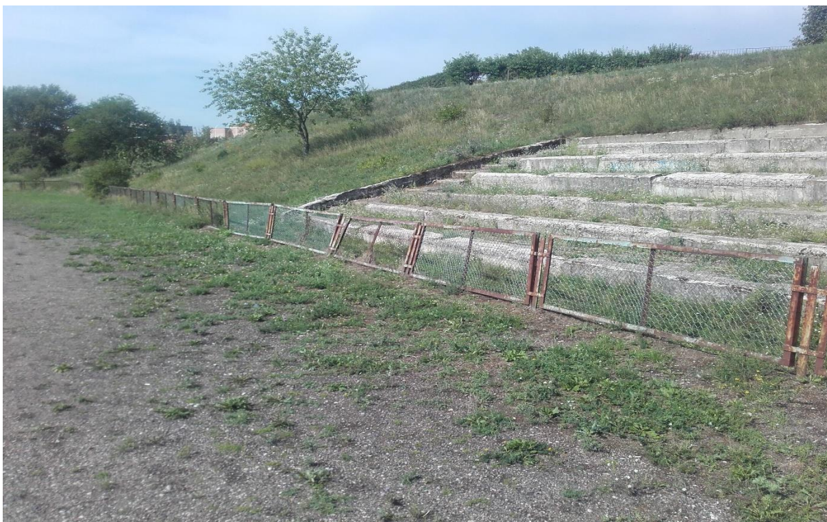
Fot nr 6 fragment bieżni 100m z ogrodzeniem
