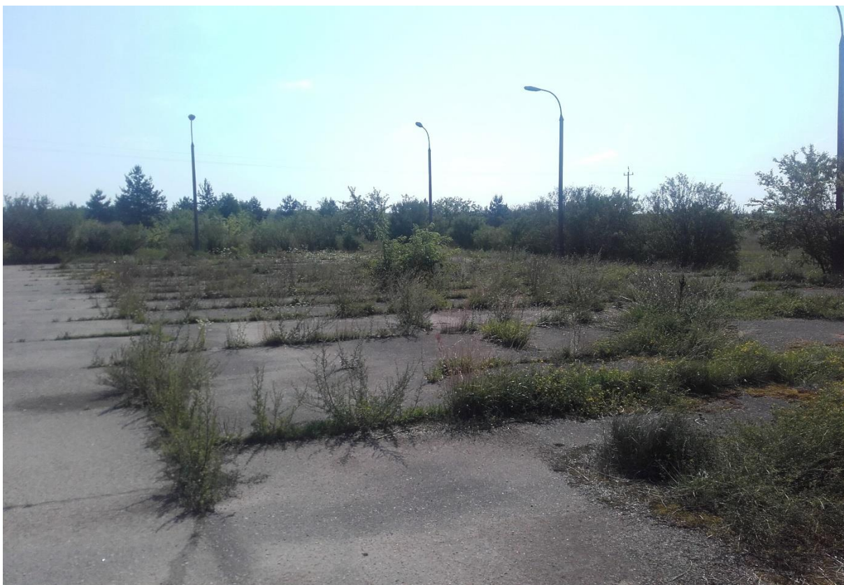
Fot nr 5 parking asfaltowy z oświetleniem
