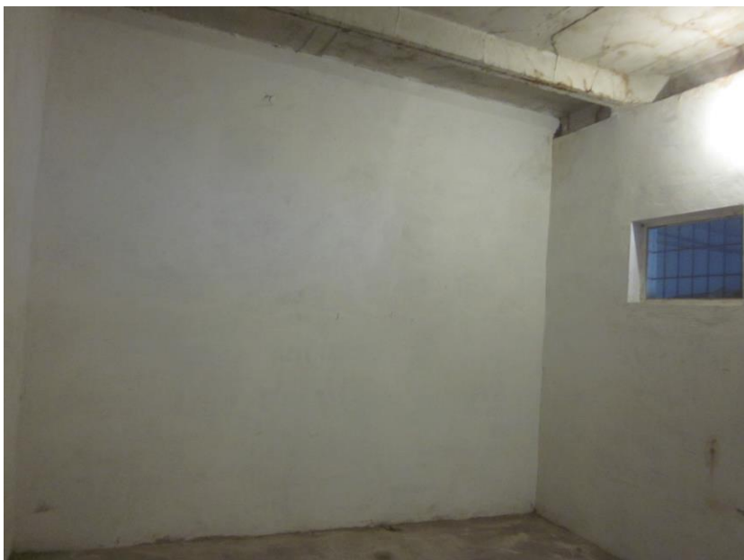
Zdjęcie własne istniejącego otworu okiennego do zamurowania
