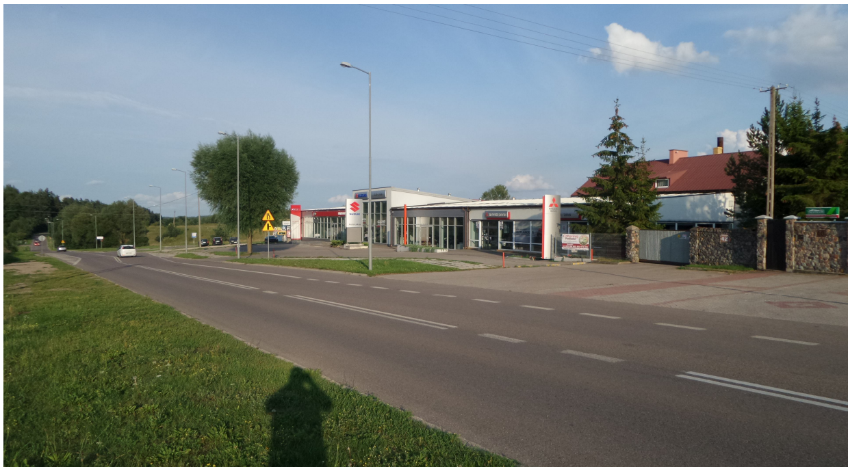
Zabudowa usługowa przy ulicy Północnej - salony samochodowe.
