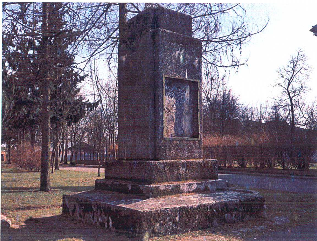
fot. nr 19 – Cokół pomnika. Otwór do wmurowania nowej tablicy pamiątkowej, metalowa rama przewidziana do demontażu.
