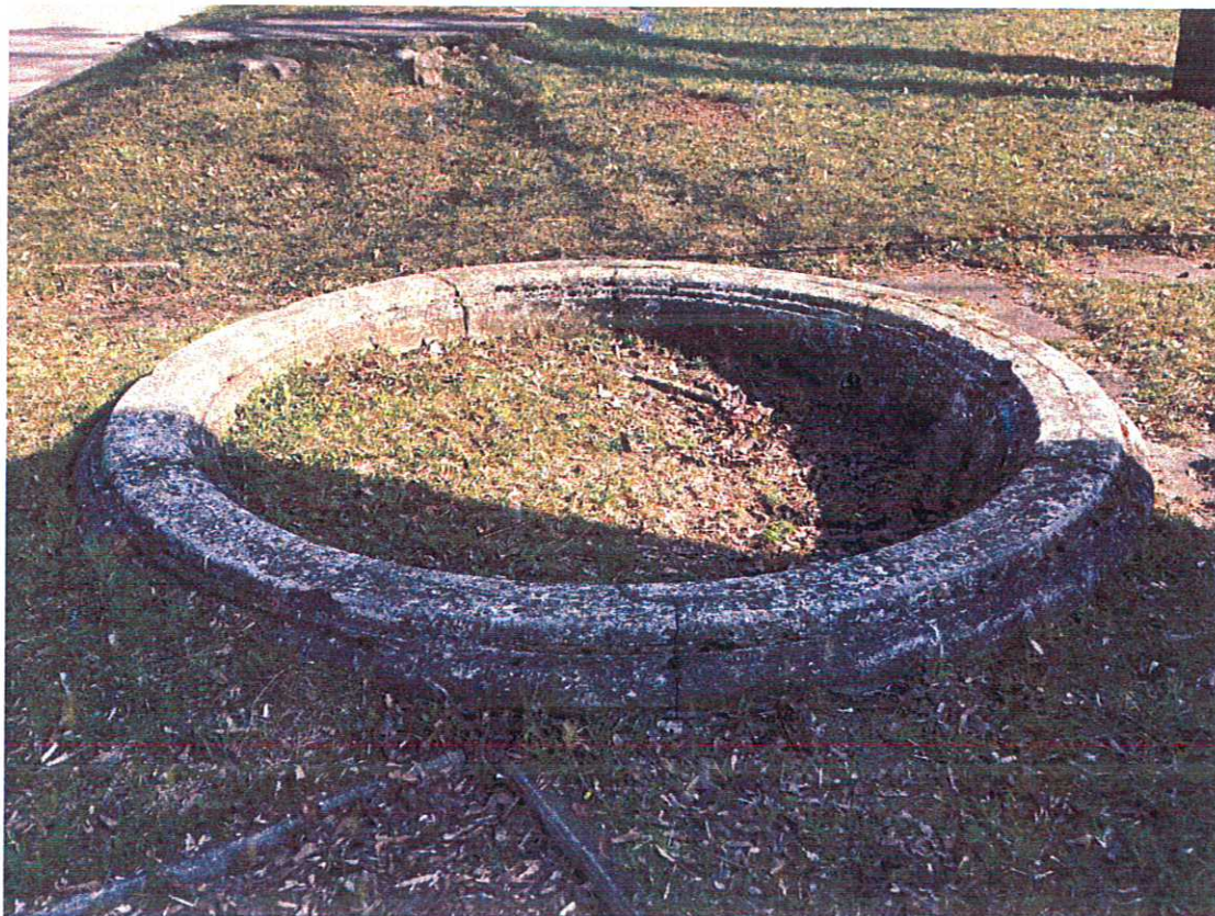
fot. nr 20 – Północny wodotrysk, przewidziany do renowacji.
