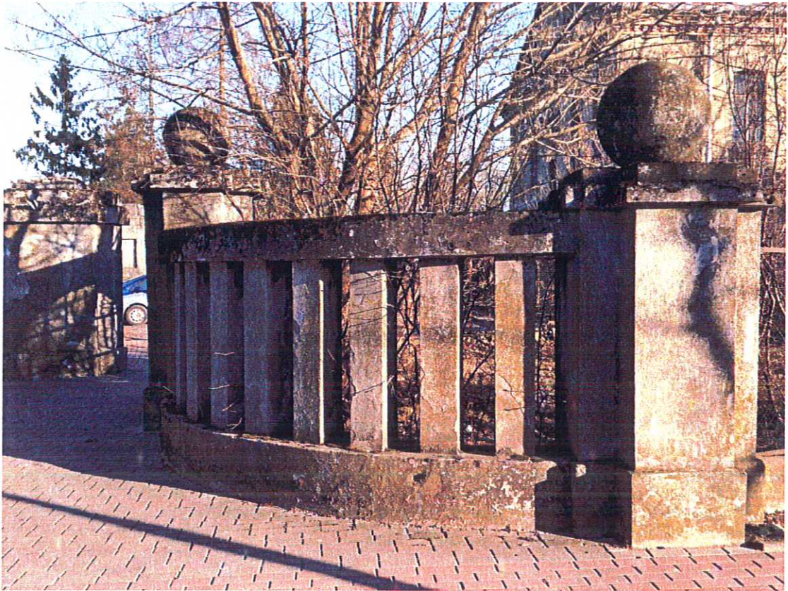
fot. nr 11 – Południowa część bramy. Roślinność za ogrodzeniem przewidziana do wycinki.
