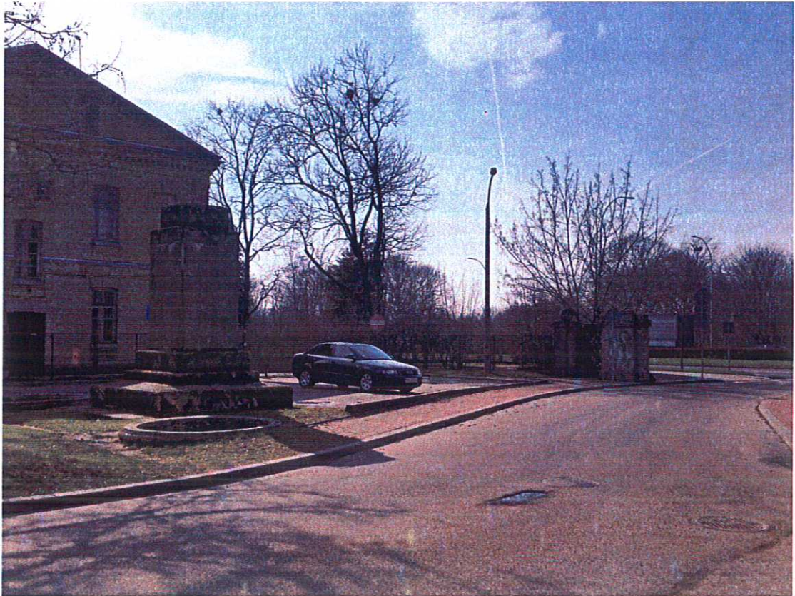
fot. nr 15 – Widok ogólny od strony północno-wschodniej, Teren przewidziany do uporządkowania.
