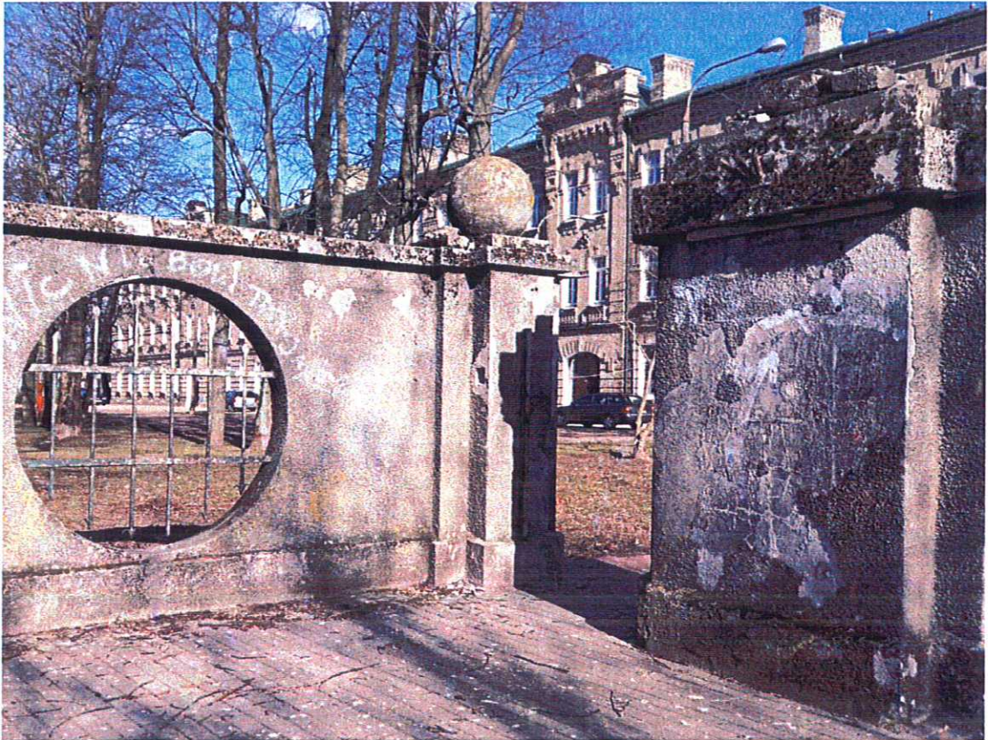
fot. nr 4 – Północna część bramy, widoczny mur z ażurowym zdobieniem, kolumna zwieńczona kulą i kolumna z cokołem pod rzeźbą.
