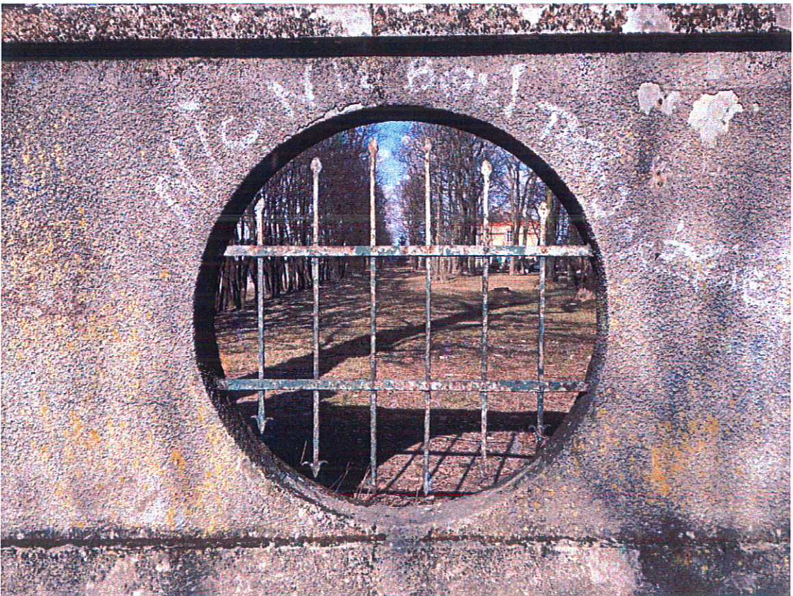
fot. nr 4 – Północna część bramy, widoczny mur z otworem i ażurowym zdobieniem.
