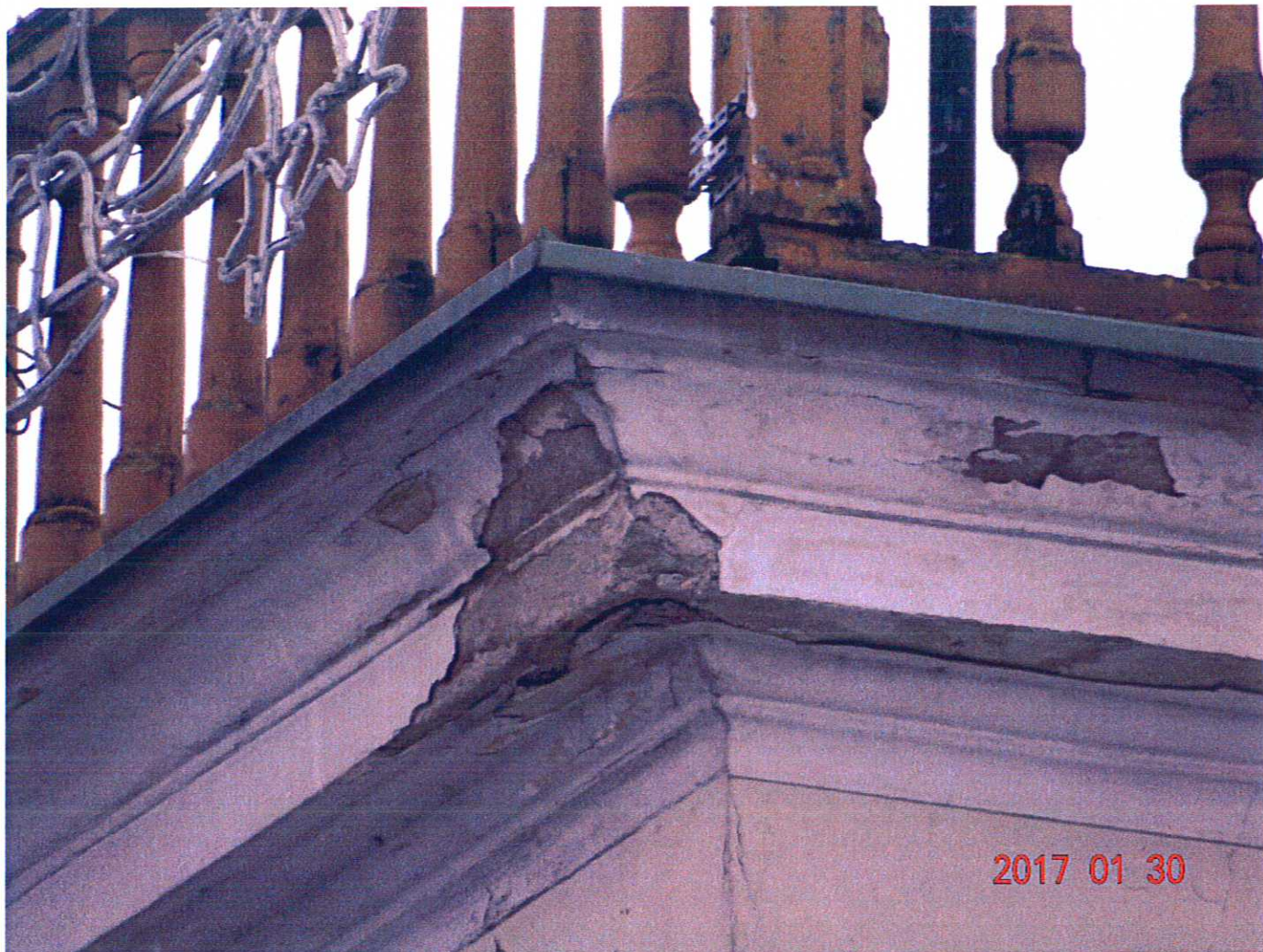
fot. nr 20 – Wieża ratuszowa. Ubytki w ozdobnym gzymsie.
