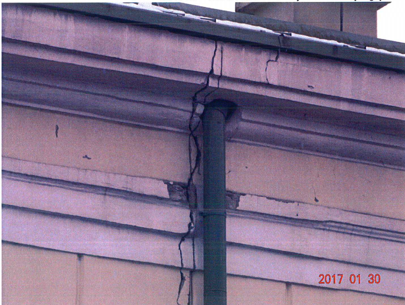
fot. nr 21 – Elewacja północna. Spękania gzymsów i elewacji.
