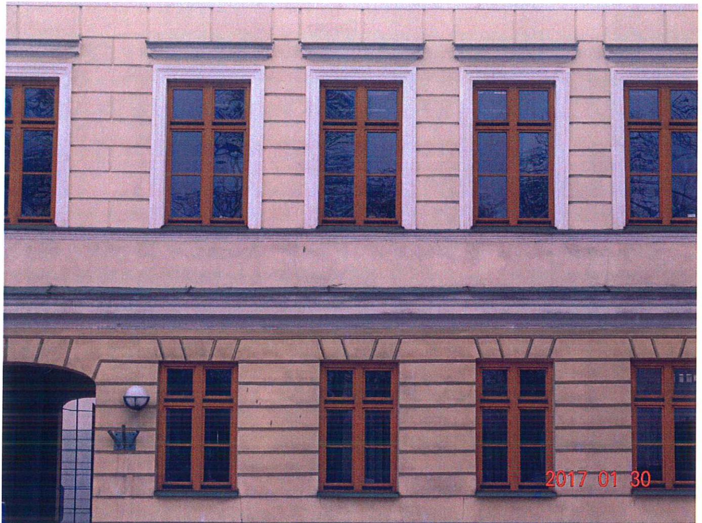
fot. nr 24 – Widok fragmentu elewacji północnej.
