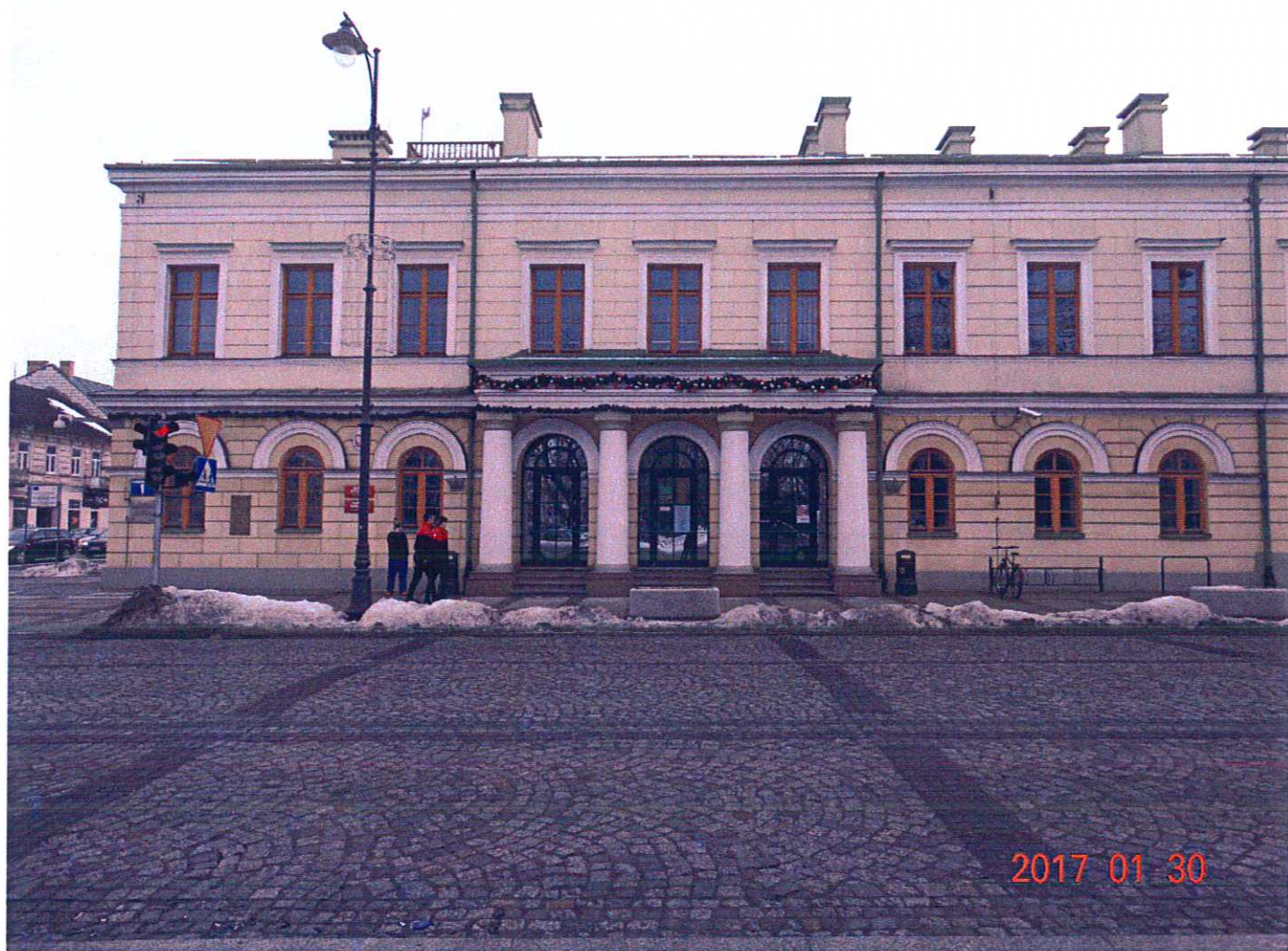
fot. nr 4 – Elewacja północna. Wejście główne.
