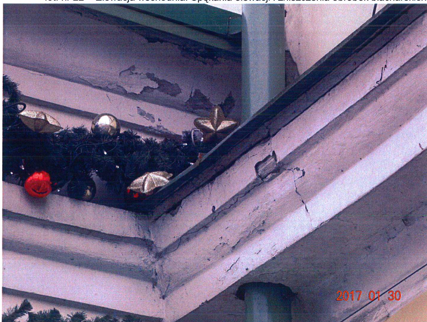
fot. nr 23 – Elewacja północna. Zniszczenia w ozdobnym gzymsie.
