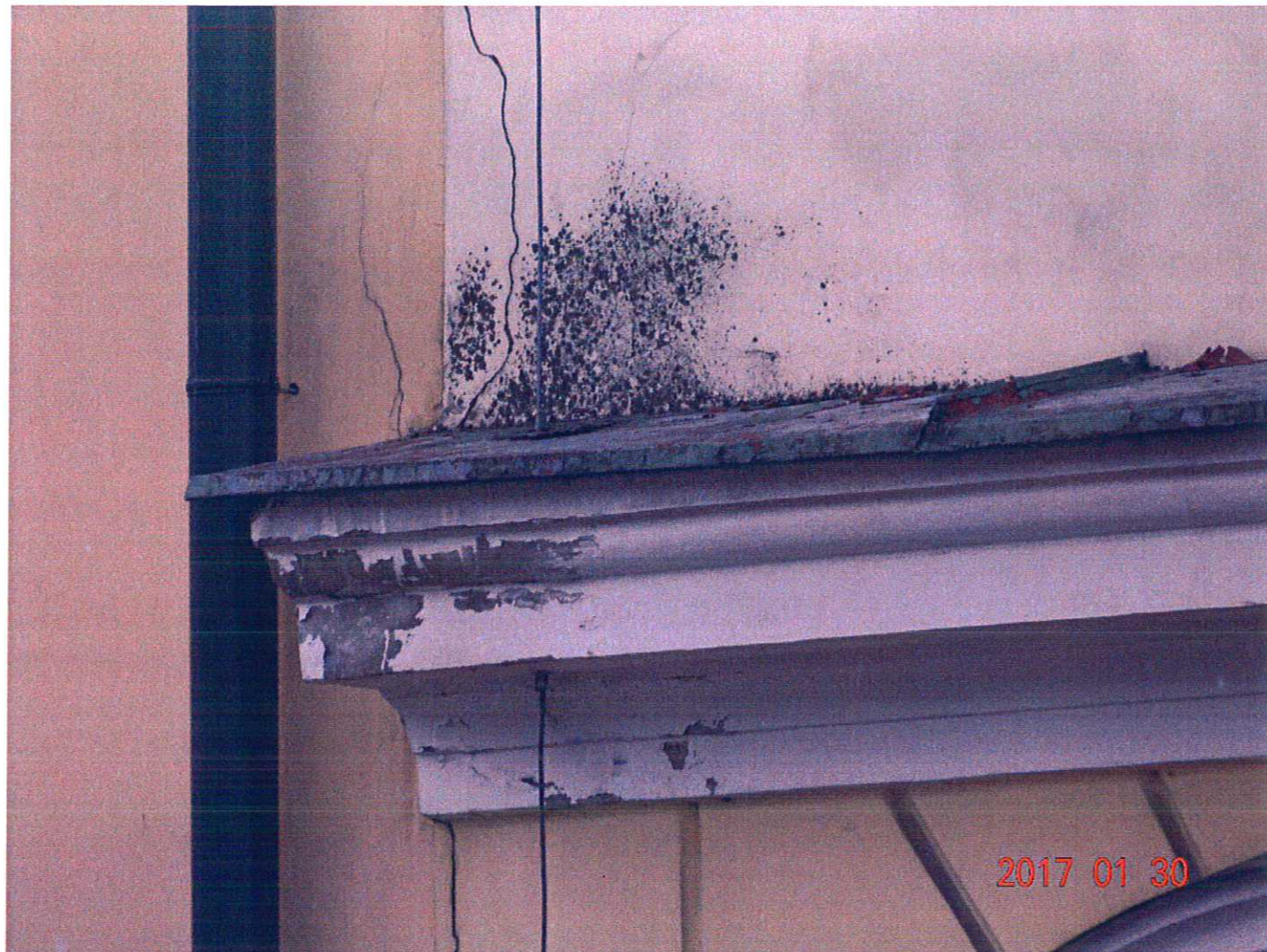
fot. nr 22 – Elewacja wschodnia. Spękania elewacji i zniszczenia obróbek blacharskich.
