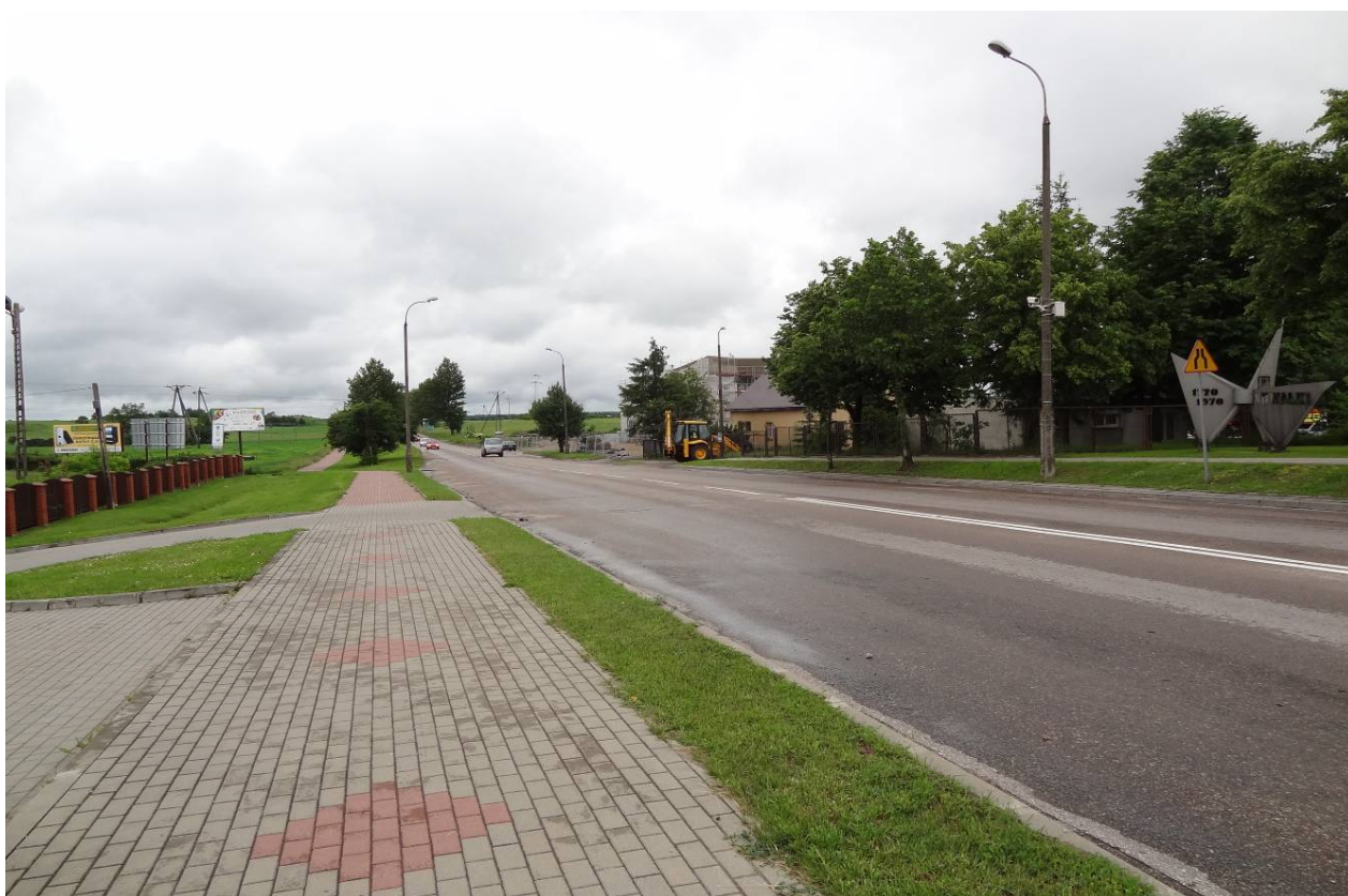
Fot.7 Koniec przekroju ulicznego
