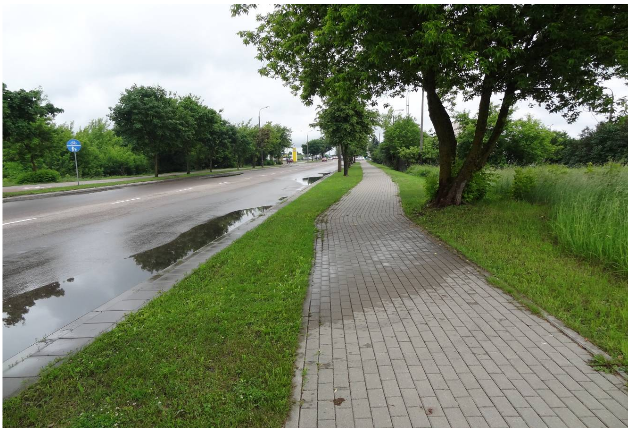
Fot.6 Odcinek ulicy Sejneńskiej za skrzyżowaniem z ul. Piaskową
