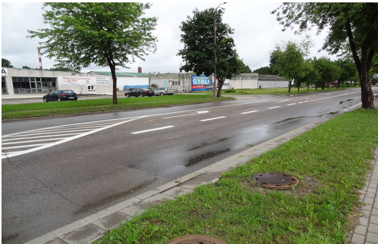
Fot.2 Odcinek ulicy Sejneńskiej pomiędzy skrzyżowaniem z ul.Młynarską i Przemysłową
