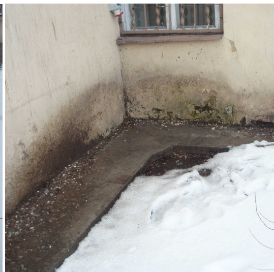
Zdjęcia nr 8, 9. Zawilgocenia opaski przechodzące na ścianę parteru.
