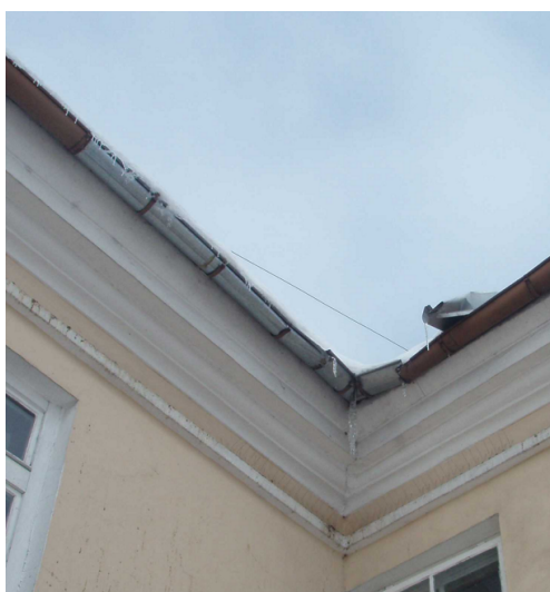
Zdjęcie nr 27. Lokalne naprawy orynowania.
