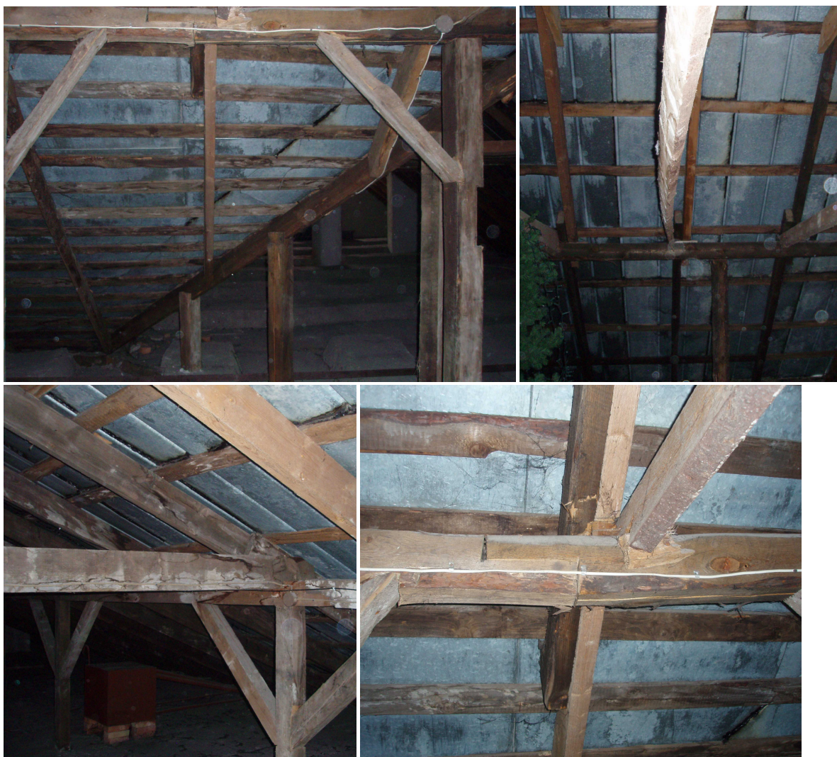
Zdjęcia nr 20, 21, 22, 23. Uszkodzenia konstrukcji więźby dachowej.
