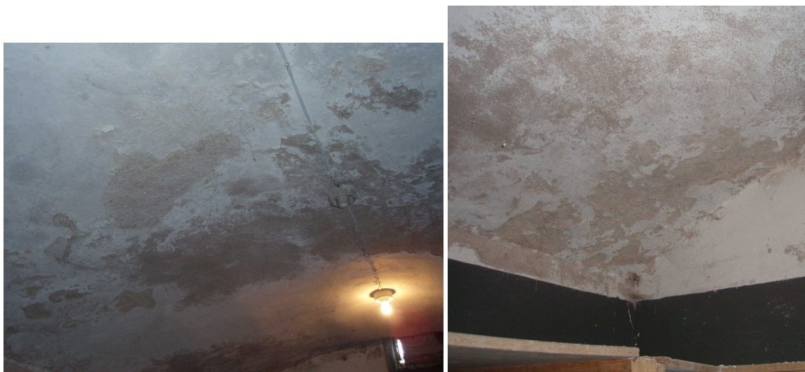
Zdjęcia nr 16, 17. Zawilgocenia stropów nad piwnicą.
