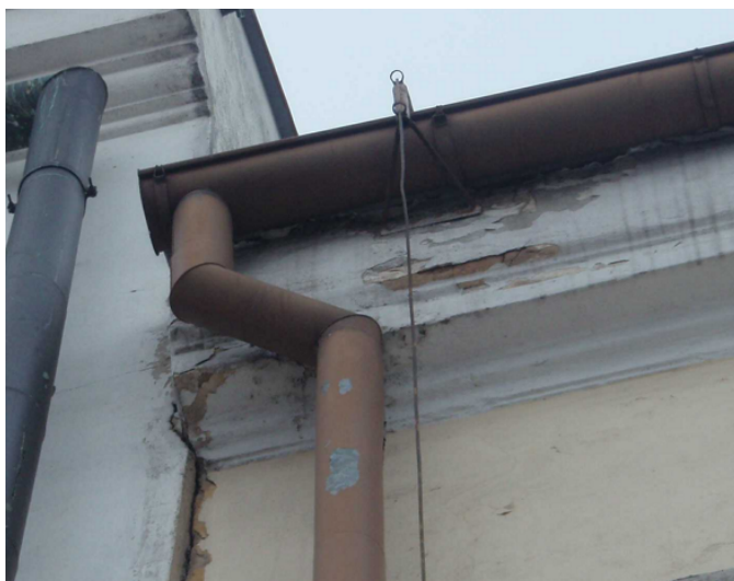
Zdjęcie nr 27. Lokalne naprawy orynowania.
