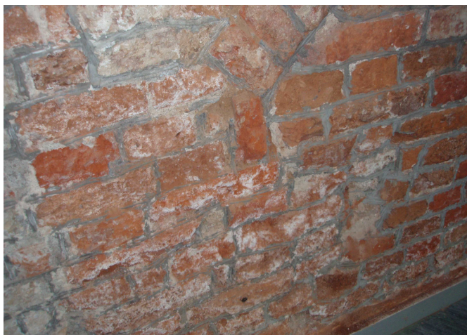
Zdjęcia nr 8, 9. Zawilgocenia opaski przechodzące na ścianę parteru.
