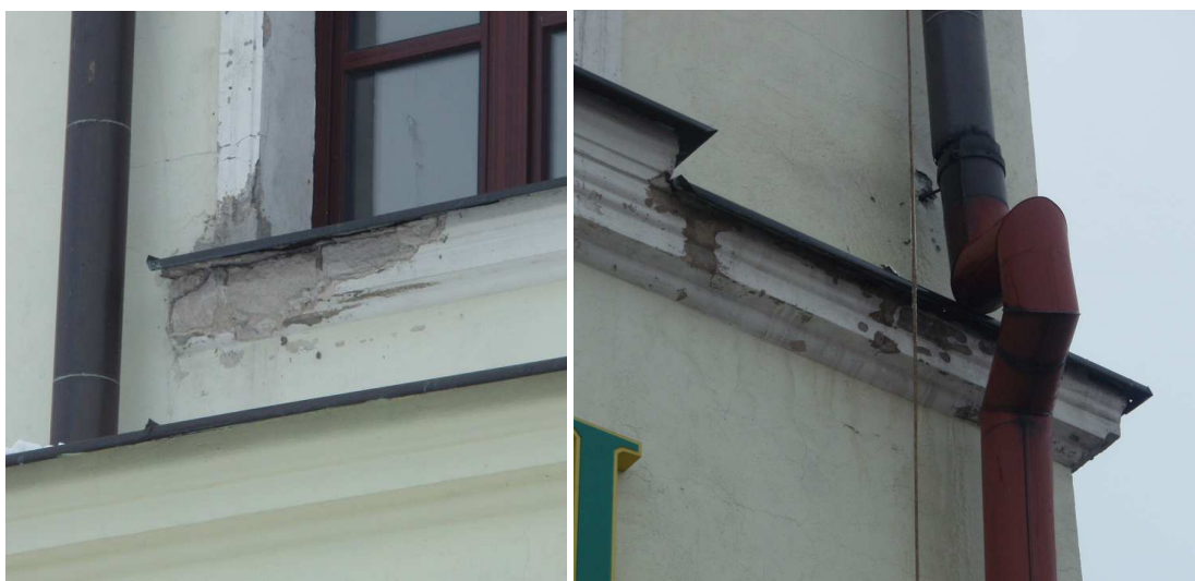
Zdjęcia nr 23, 24. Uszkodzone gzymsy pod parapetami.
