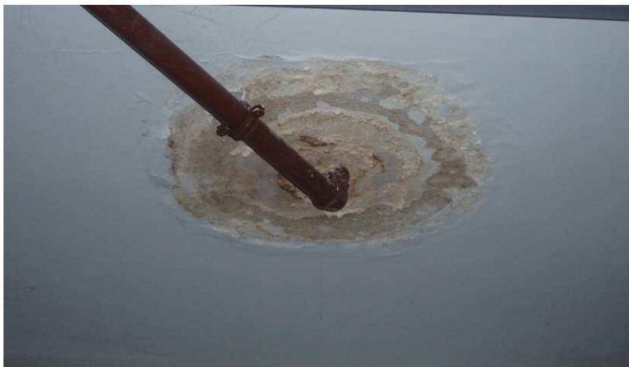
Zdjęcia nr 17, 18. Konstrukcja dachu nad częścią główną.
