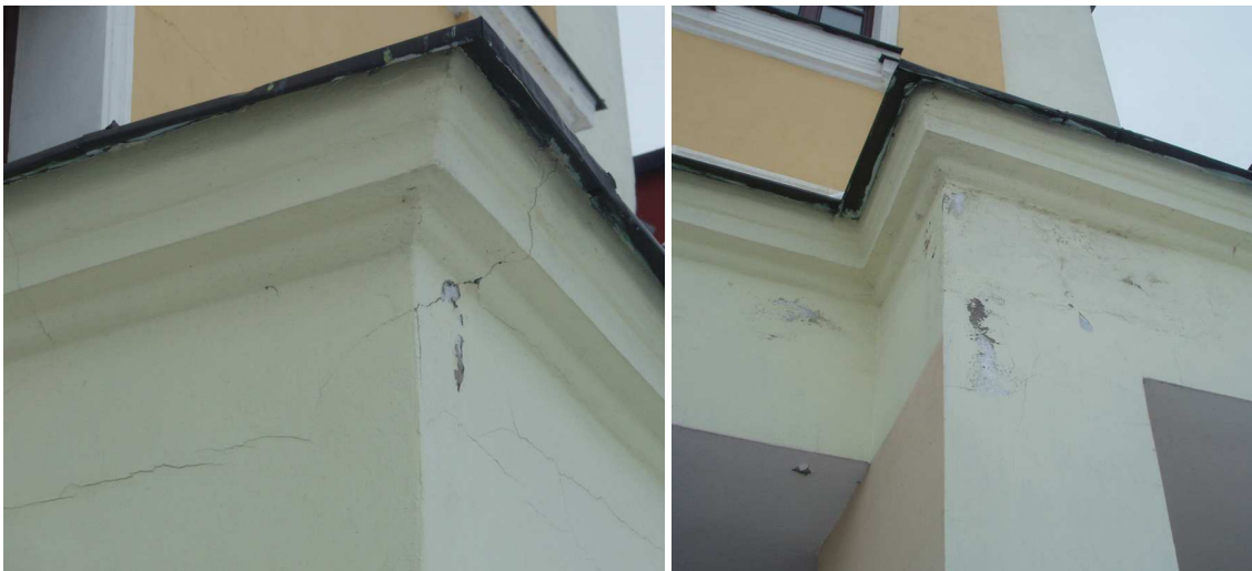
Zdjęcia nr 12, 13, 14,15. Zarysowania warstwy ściany licowej.
