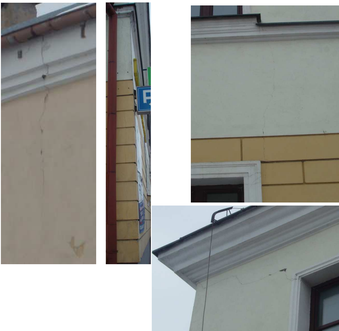
Zdjęcia nr 12, 13, 14,15. Zarysowania warstwy ściany licowej.
