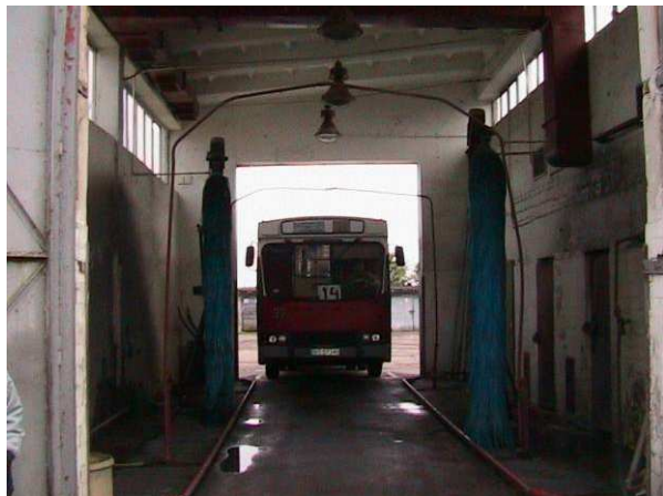
Fot. 21. Zajezdnia Zakładu Komunikacji Miejskiej PGK - myjnia autobusowa.
