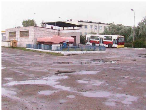
Fot. 24. Zajezdnia Zakładu Komunikacji Miejskiej PGK - stacja paliw.
