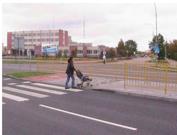
Fot. 26. Ul. Pułaskiego – rozwiązanie przejścia dla pieszych zabezpiecza przed wtargnięciem pieszych na jezdnię ulicy
