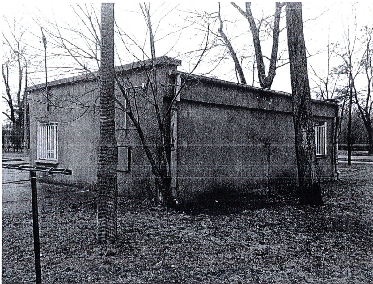
Fot nr 3 – budynek nr 24a, elewacja wschodnia i północna, działka o nr geod 22935/5.
