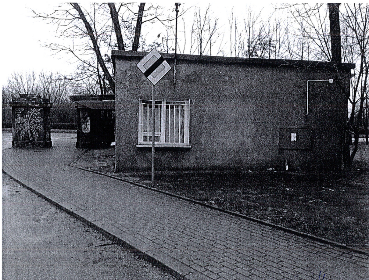
Fot nr 2 – budynek nr 24a, elewacja wschodnia, działka o nr geod 22935/5.
