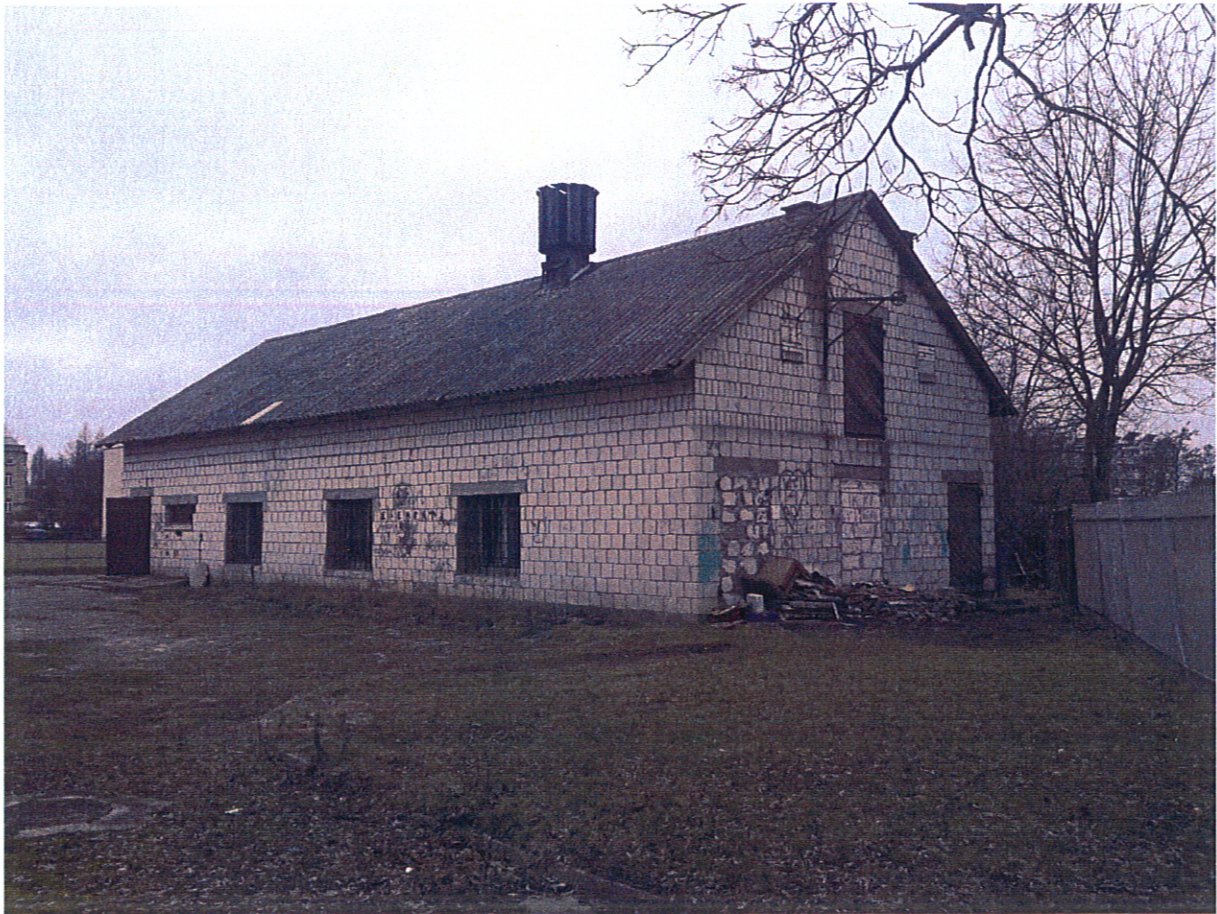
Fot nr 3 – Budynek gospodarczy, elewacja północna i wschodnia (działka o nr geod. 10682/5).
