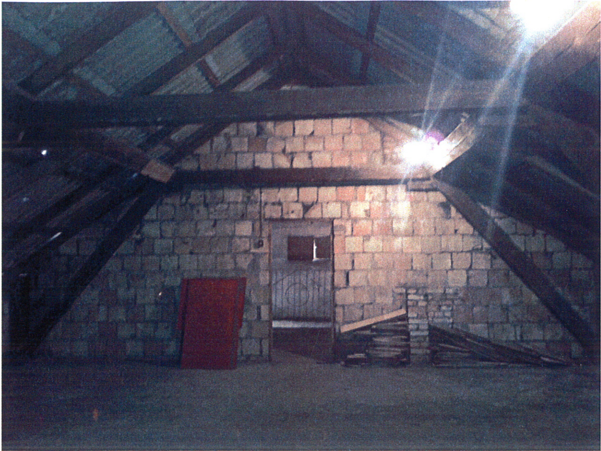
Fot nr 7 – Budynek gospodarczy, poddasze (działka o nr geod. 10682/5).
