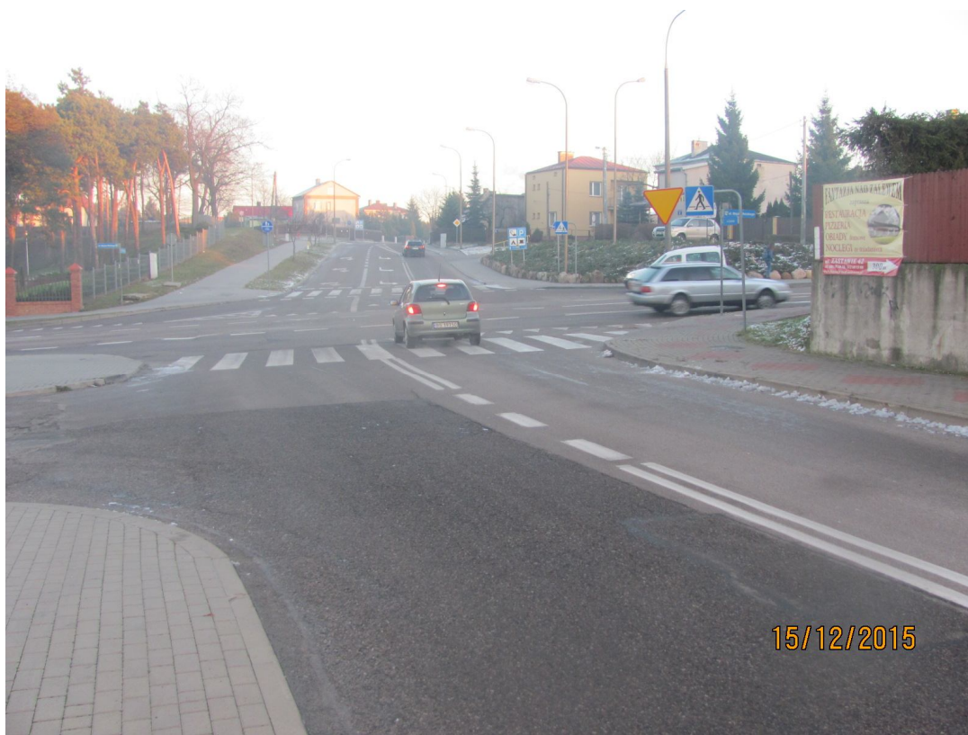
Fot. Nr 4 wlot zachodni – ulica Zastawie.
