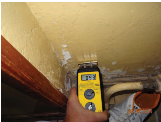
Fot. 38. Pomiar wilgotności w strefie pokazanej na fot. 37.
