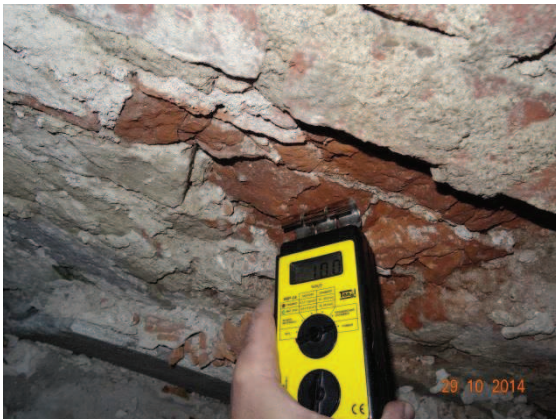
Fot. 27. Pomiar wilgotności w strefie osłoniętej.
