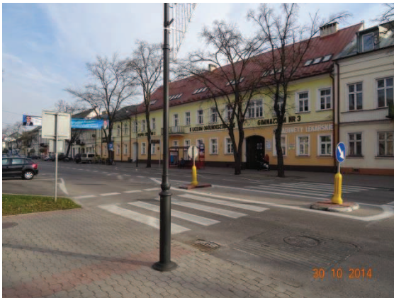
Fot. 1. Widok ogólny elewacji frontowej budynków Zespołu Szkół nr 2 w Suwałkach.
