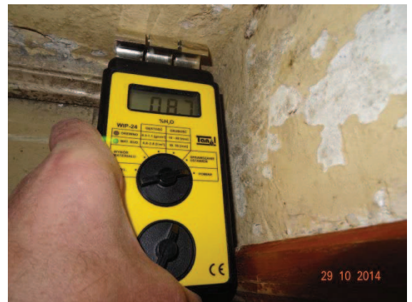
Fot. 35. Budynek mniejszy. Parter. Złuszczenia tynku i lamperii olejnej na podokienniku ściany tylnej budynku.
