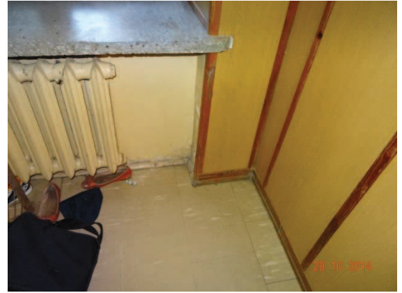
Fot. 35. Budynek mniejszy. Parter. Złuszczenia tynku i lamperii olejnej na podokienniku ściany tylnej budynku.
