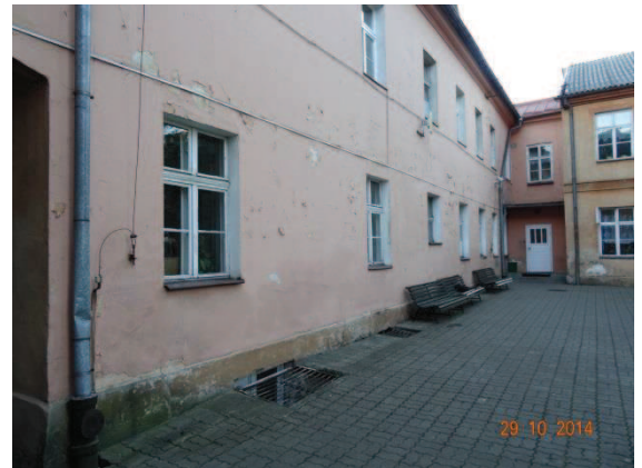
Fot. 4. Widok ogólny ściany tylnej budynku głównego.
