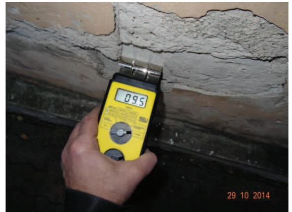
Fot. 6. Jak fot. 5, lecz pomiar wilgotności muru.
