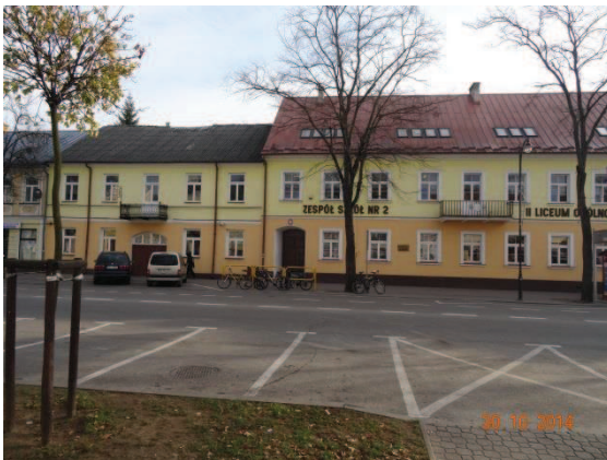
Fot. 3. Fragment elewacji frontowej z budynkiem mniejszym.
