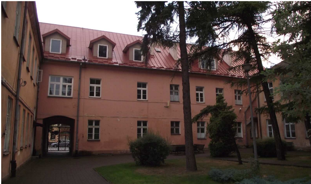
Elewacja wschodnia budynku frontowego nr 36
