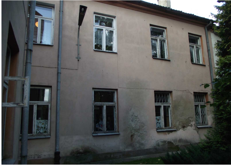
Elewacja wschodnia budynku frontowego nr 38
