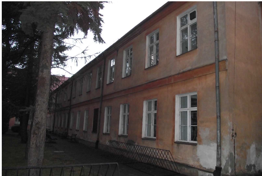
Elewacja południowa oficyny północnej
