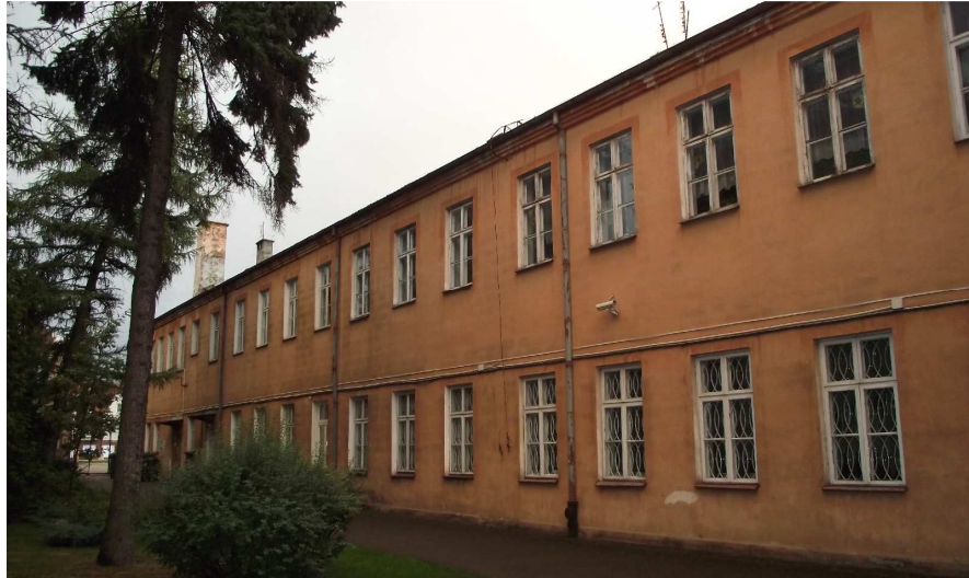
Elewacja północna oficyny południowej
