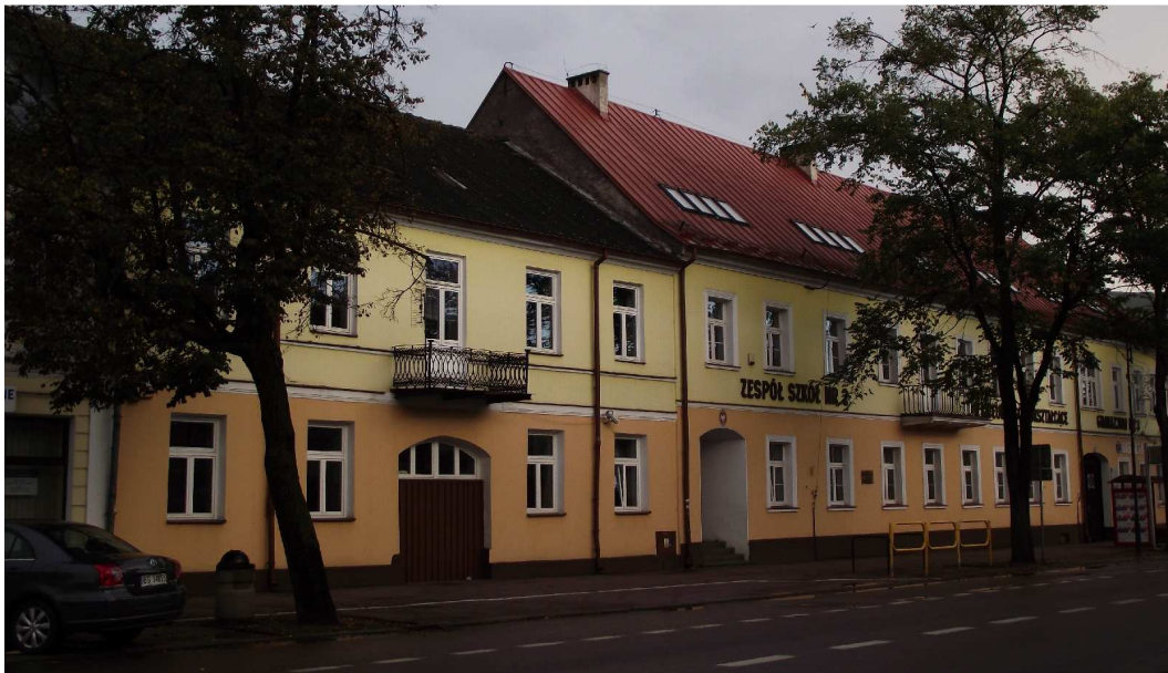
Elewacja frontowa budynku frontowego
