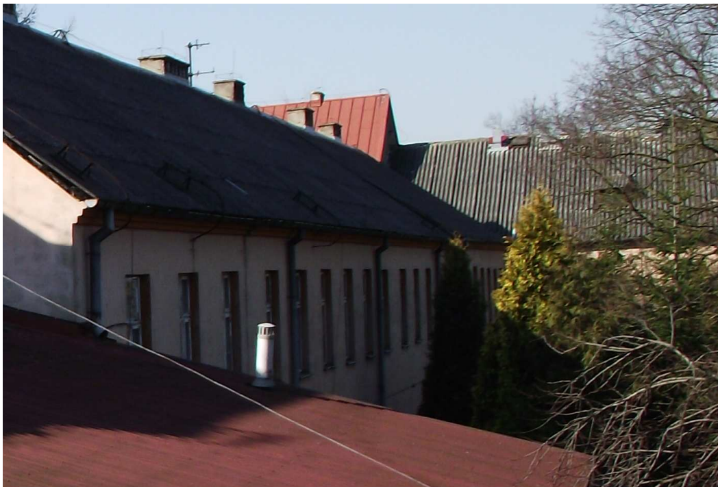
Widok na dach oficyny północnej oraz budynku nr 38 (po prawej) od podwórza
